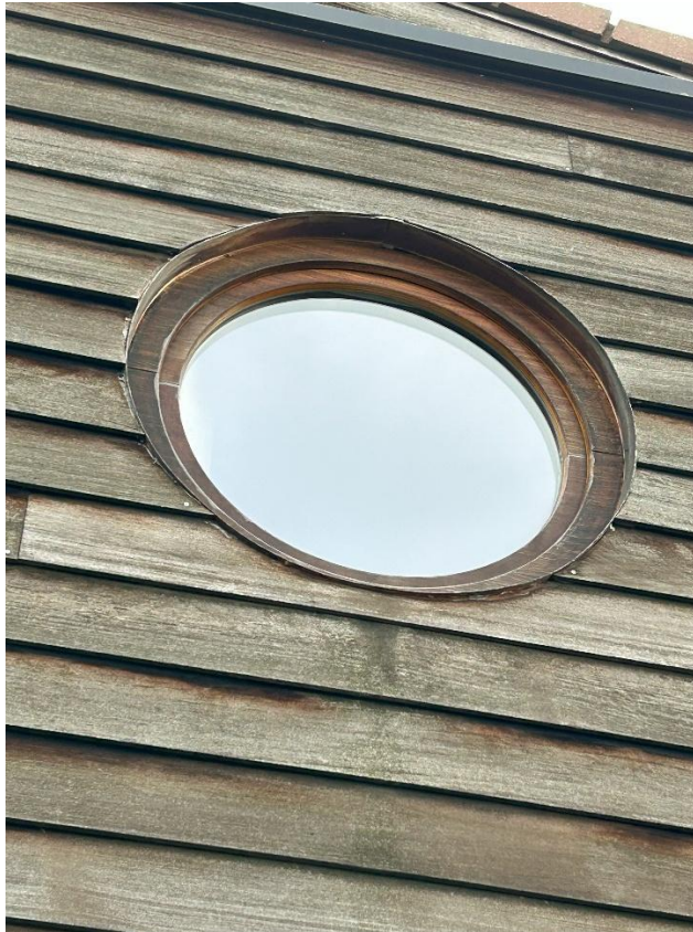
Rond kozijn in WRC gevelbekleding achterzijde woning
