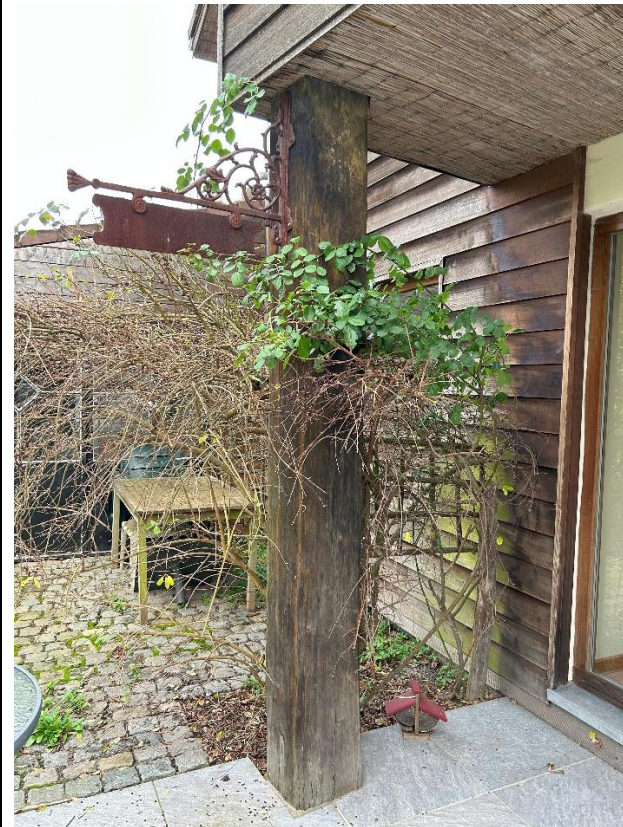
Ondersteuning uitgebouwde slaapkamer (oude meerpaal)
