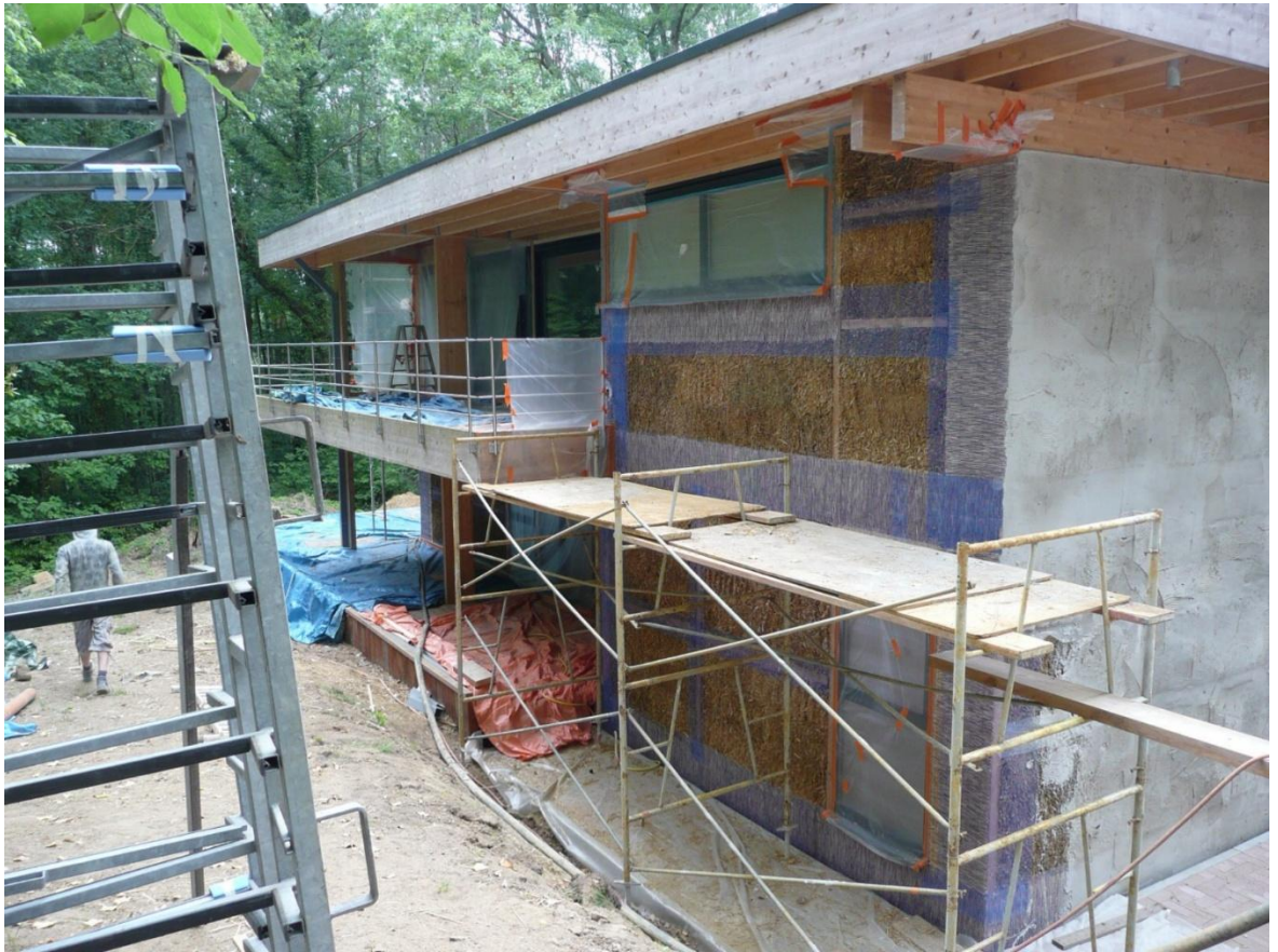
7. Aanbrengen gevelbekleding
