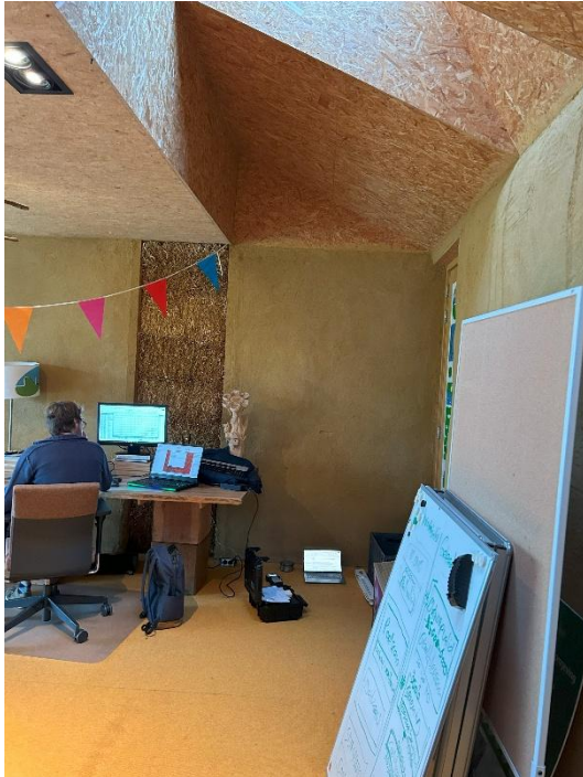
Linkerzijde van het kantoor (van de voorzijde van het kantoor gezien) met de strook stro in het zicht. Deze wand grenst aan de buitenlucht onder de overkapping.
