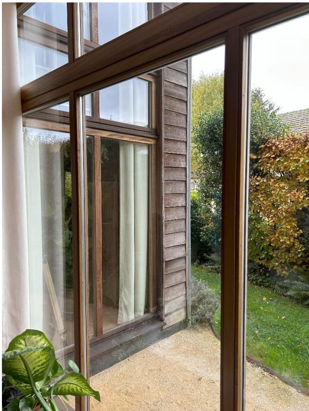
Afrormosia kozijnen. Aan de binnenzijde onbehandeld, aan de buitenzijde transparant afgewerkt
