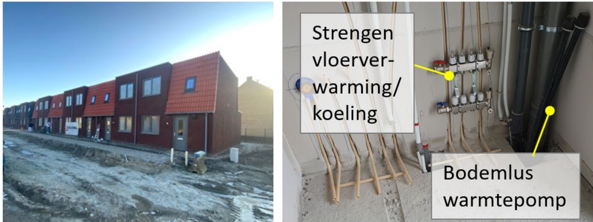
Figuur 13: Aanzicht van de NeroZero woningen in Dijk en Waard en een deel van het warmteafgiftesysteem.
