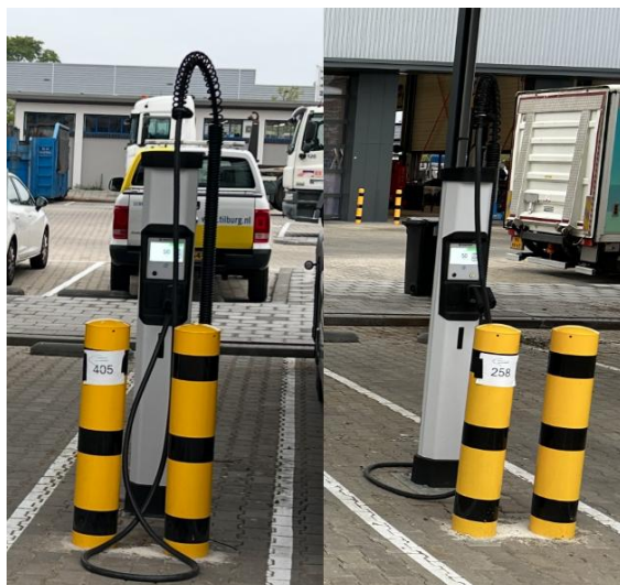
Figuur 3.10: Kampower satelliet met kabelbeheersysteem bij BAT.
