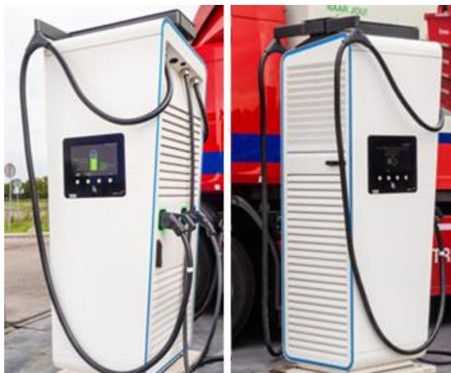
Figuur 3.15: Alpitronic lader met kabelbeheersysteem bij Circle K.
