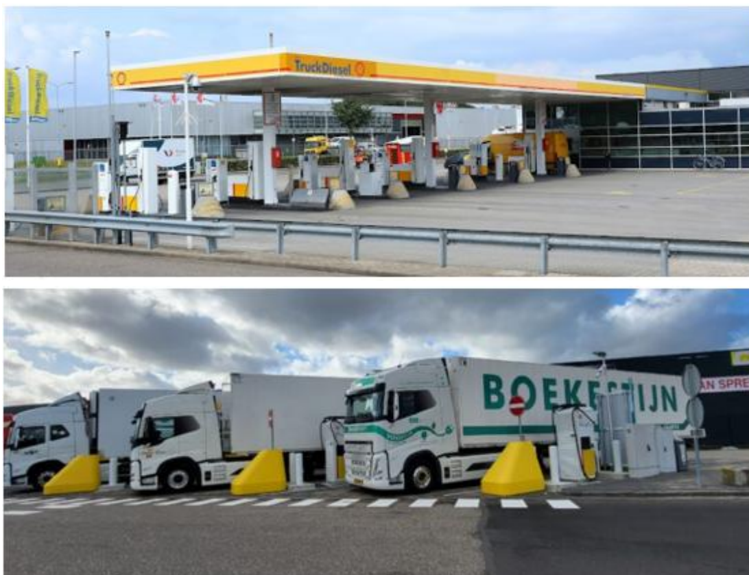
Figuur 3.17: Overzicht van het tankstation en laadplekken van Shell te Eindhoven.
