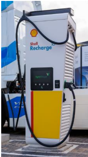
Figuur 3.21: Alpitronic lader met kabelbeheersysteem bij Shell.
