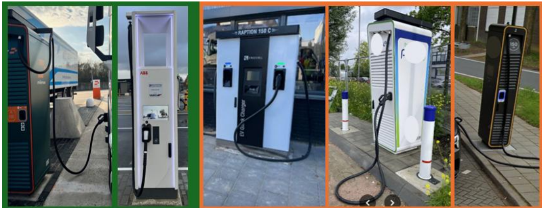
Figuur 4.8: Voorbeelden van laders met en zonder kabelmanagementsysteem en het effect op de kabel. Deze foto's zijn niet genomen op de betrokken laadpleinen.
