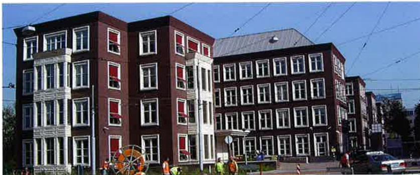
Een voorbeeld van de onderzochte ING panden.
