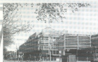
Dynamisch Kantoor (c).
