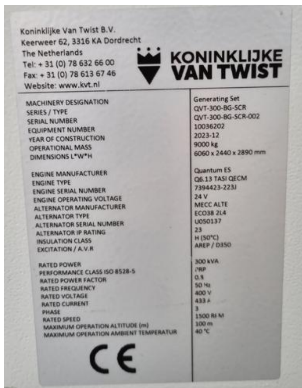
Figuur 2.2: Typeplaatje van de generatorset met enkele specificaties van de motor en de generator.
