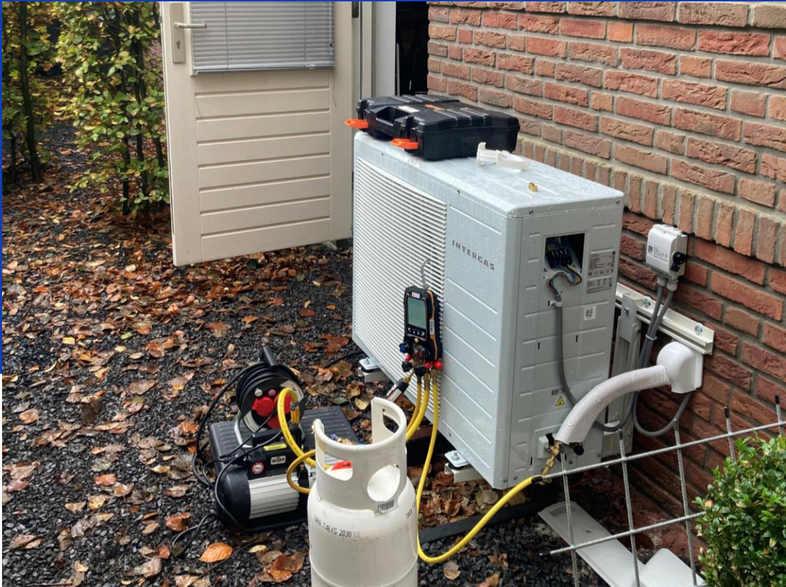
Het bijvullen en controleren van de druk in de koelleidingen.
