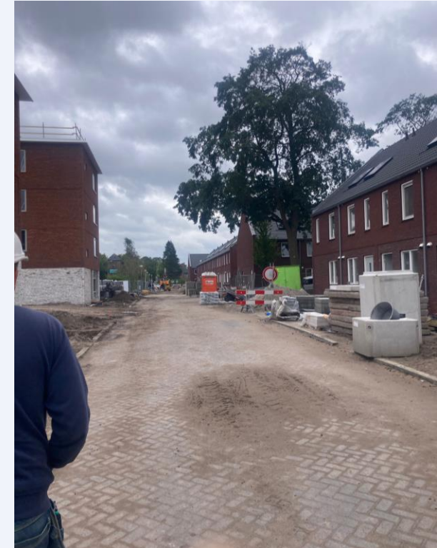
Monteur leidt rond op bouwplaats waar prefab pompen zijn geïnstalleerd in nieuwbouw.
