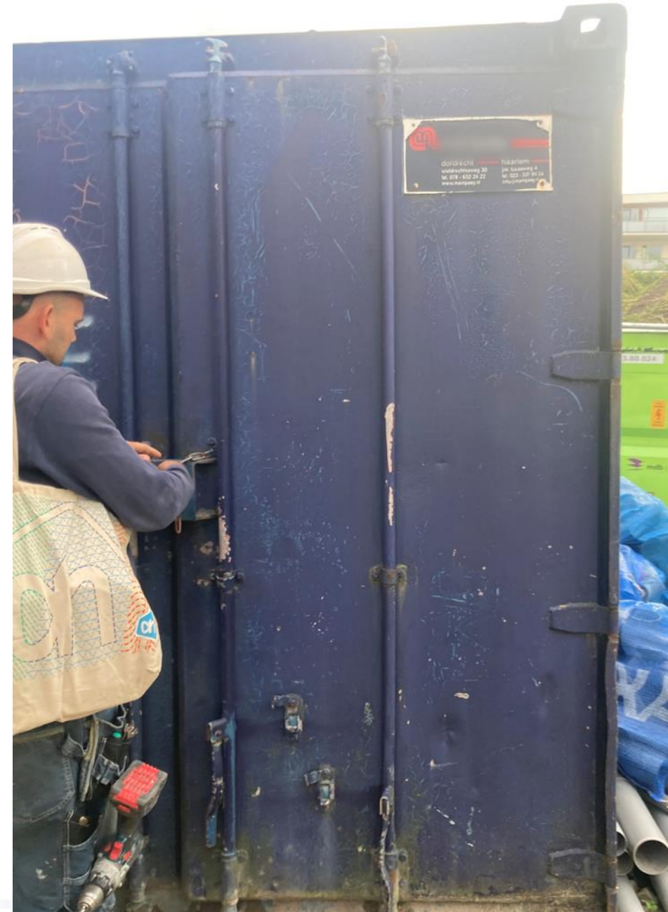
Afsluiten van de werkcontainer met het gereedschap op een bouwplaats.
