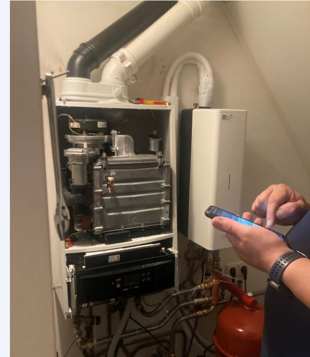
Monteur stelt nieuwe installatie in via een website op zijn mobiel.
