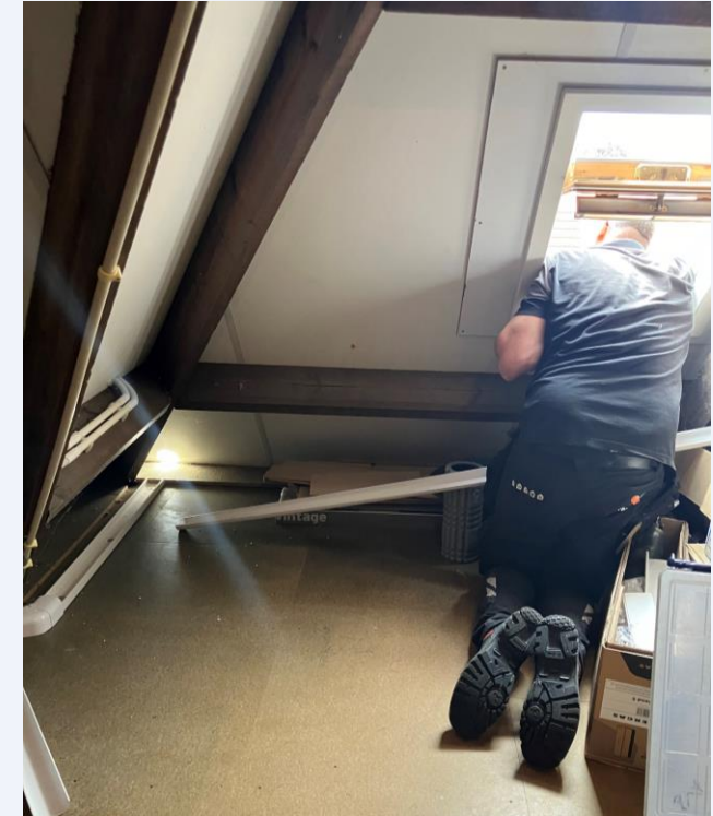
Monteur communiceert met collega die bij buitenunit staat.
