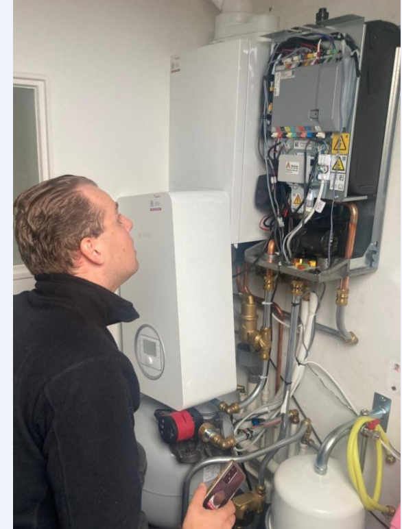
Monteur controleert of nieuwe pomp (rood/zwart, linksonder) goed werkt.
