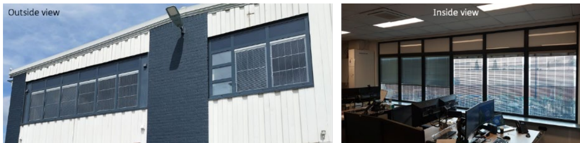
Figuur 19: Grote prototypes in de zuidgevel van het Pilkington Experience Center in Enschede. Links: buitenaanzicht, Rechts: binnen aanzicht van kantoordeel achter ramen P1 t/m P6.
