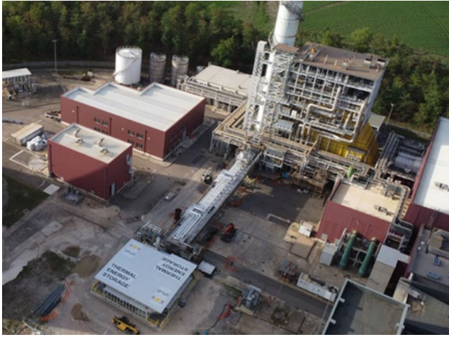
Figuur 2.6: Brenniler warmteopslag bij de Enel elektriciteitscentrale (Italië)
