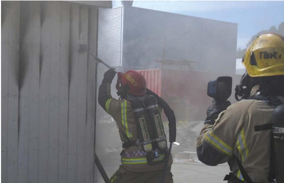
Figuur 10: Het lokaliseren en blussen van een brand in een verstopte holle ruimte d.m.v. een thermische camera en een snijblusser, uit Hox en Saeter Boe (2017).
