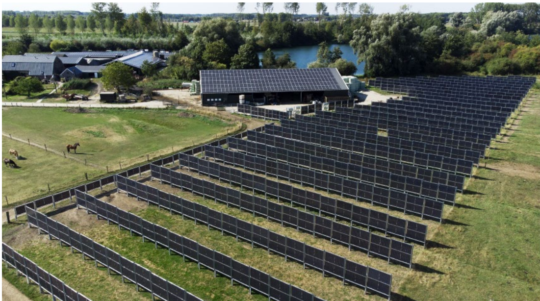
Figuur 3.8: Verticale bifaciale zonnepalen voor agrarische toepassingen (Energie Coöperatie Vrijstad)
