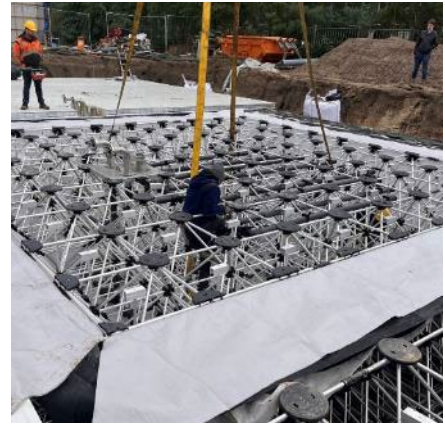
Figuur 6: Installatie van een HoCoSto warmteopslagmodule
