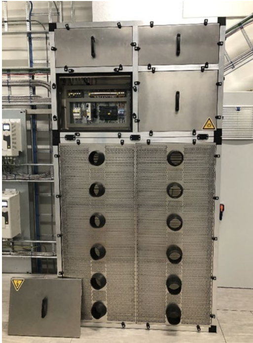
Figuur 25. Geïntegreerde PCM modules in klimaatsysteem van DuraFlow
