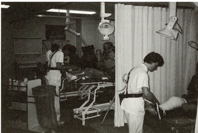
MOBIELE PUNTAFZUIGERS IN DE GIPSKAMER VAN EEN ZIEKENHUIS ZORGEN ER VOOR DAT BIJ ELKE PATIËNT DE SCHADELIJKE DAMPEN WORDEN OPGEVANGEN DIE BIJ DE CHEMISCHE REACTIE VAN HET KUNSTGIPS VRIJKOMEN. HET GEBRUIK LAAT ECHTER TE WENSEN OVER. FOTO TNO-BOUW
