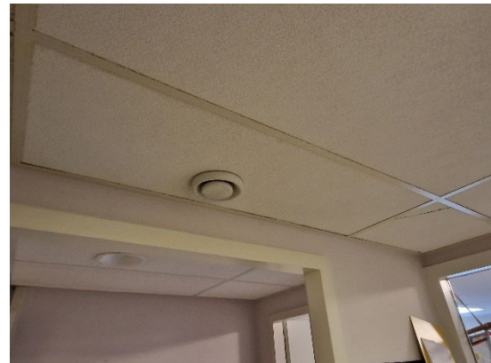
Figuur 3.4 Het afvoerrozet in het plafond van het aangrenzende kantoor
