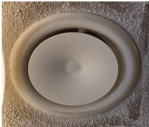
Figuur 3.3 Voorbeeld van toevoerrozet in ruimte
