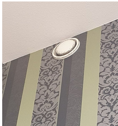
Figuur 4.4 Close-up van het afvoerrozet
