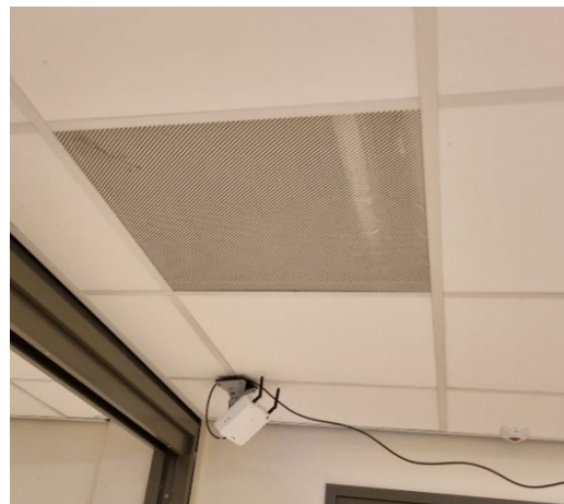
Figuur 7.4 Voorbeeld van een geperforeerd rooster om de mechanisch af te voeren lucht toegang te geven tot het plenum waar de afvoerslang is gelegen
