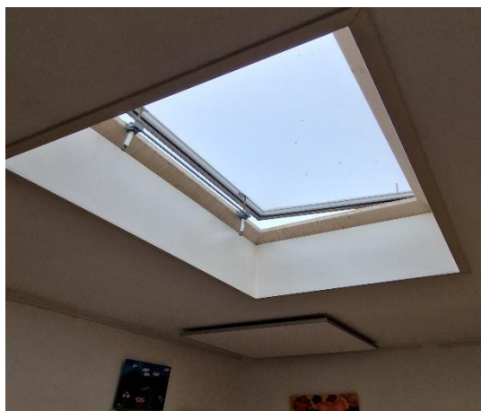
Figuur 4.6: Voorbeeld van toevoer raam in ruimte 2
