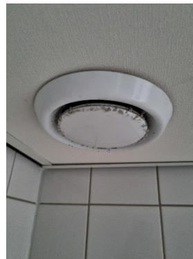
Figuur 3.11 Voorbeeld van een afvoer rozet in een nabijgelegen ruimte.
