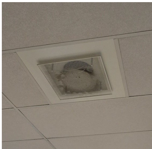
Figuur 6.2 Foto van een geperforeerd toevoerrooster in de ruimte
