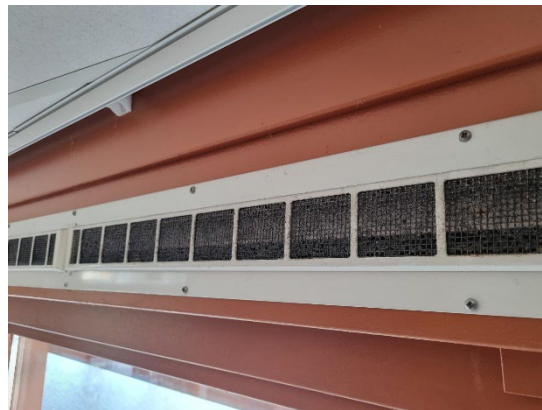
Figuur 6.4: Raamrooster in de ruimte
