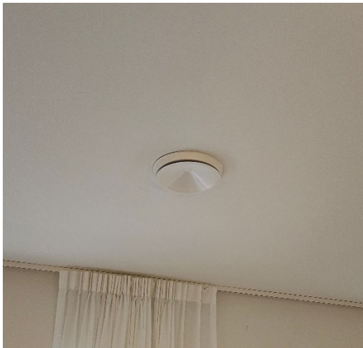
Figuur 7.7 Voorbeeld van een toevoerrozet in de ruimte
