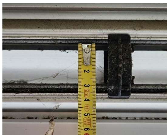
Figuur 2.2: Opmeten netto doorlaat ventilatiooroster.
