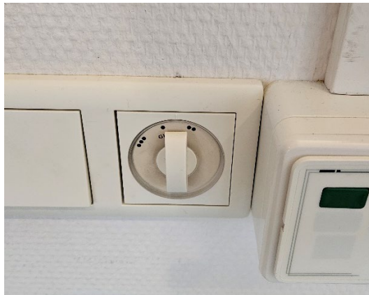
Figuur 10.7 De standenschakelaar voor de afvoerventilator
