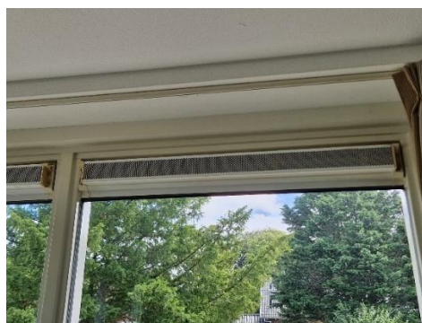
Figuur 3.27: Voorbeeld van toevoer raamrooster in ruimte 2
