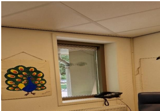
Figuur 3.19: Voorbeeld van een toevoerrooster boven het raam in ruimte 2
