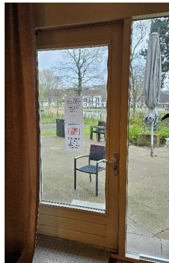
Figuur 7.10 Voorbeeld van een te openen geveldeel in de ruimte
