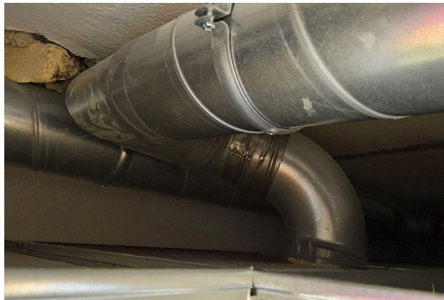
Figuur 6.4 Voorbeeld van een toevoerkanaal boven het plenum.
