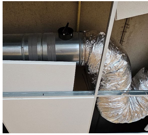
Figuur 3.4 Aanzicht van het plenum. Te zien is een verstelbare klep in het luchtkanaal
