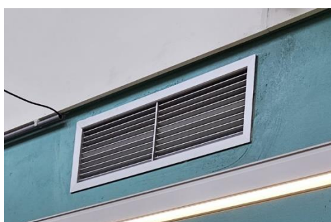
Figuur 6.9: Toevoerrooster boven keuken .
