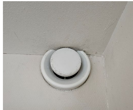
Figuur 10.12 Eén van de twee afvoerrozetten.
