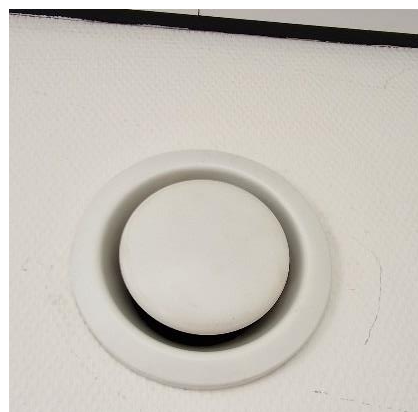
Figuur 3.16: Voorbeeld van afvoerrozet ruimte 1
