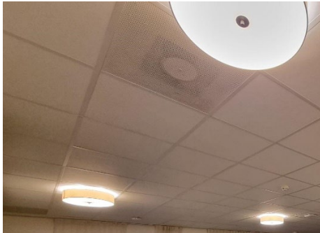
Figuur 4.6: Voorbeeld van één toevoerrooster in de ruimte
