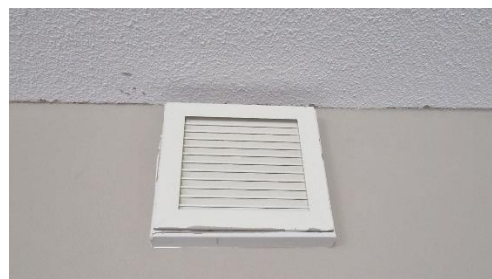
Figuur 3.8 Voorbeeld van een overstroombrooster (afvoer) in ruimte 2
