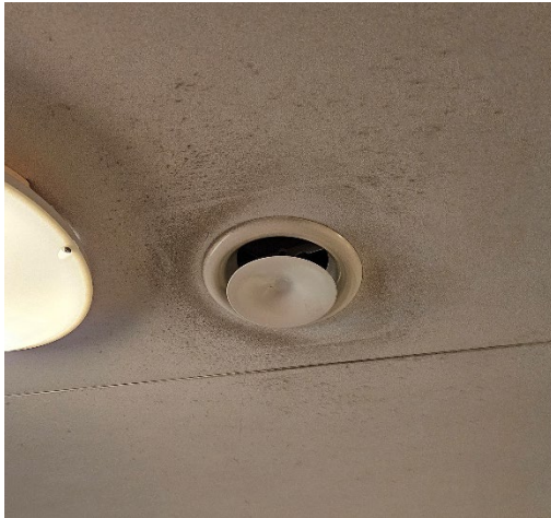
Figuur 9.7 Een van de twee toevoerrossetten.
