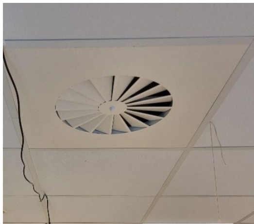
Figuur 7.3 Voorbeeld van een wervelrooster voor de mechanische toevoer van lucht
