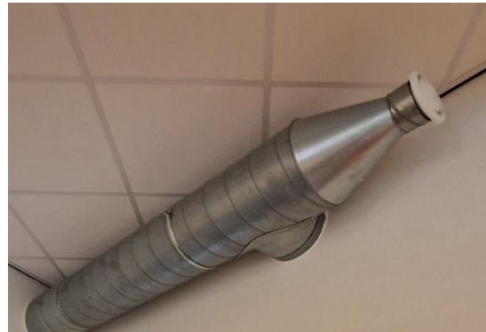
Figuur 3.20: Voorbeeld van afvoerrozet ruimte 2
