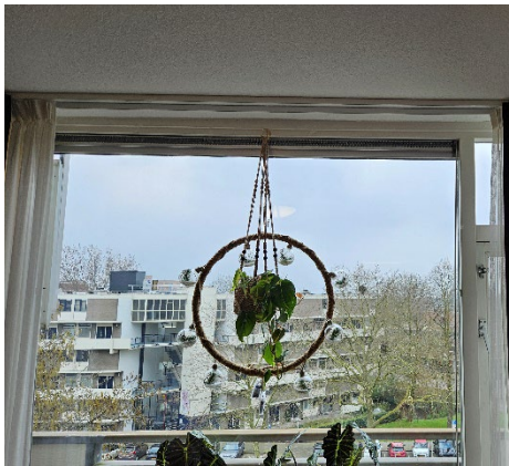
Figuur 6.3 Voorbeeld van een raamrooster in de ruimte
