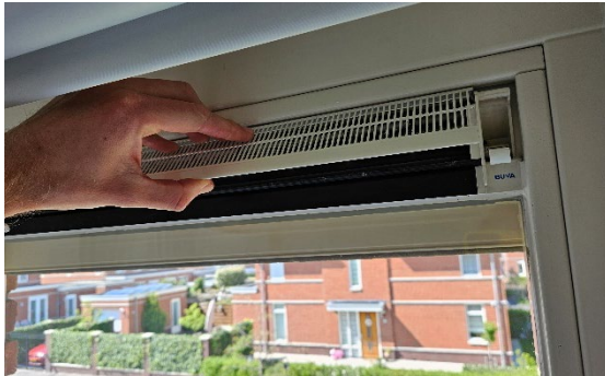
Figuur 3.6: toevoerroosters openen om te reinigen
