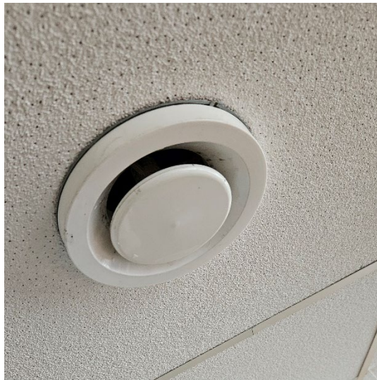
Figuur 10.3 Afvoerrozet in de ruimte
