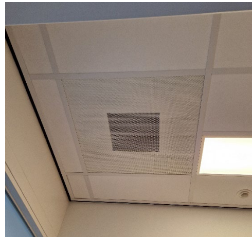
Figuur 3.8 Voorbeeld van afvoerrooster in naastgelegen bijkeuken
