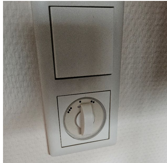
Figuur 10.4 De standenschakelaar
