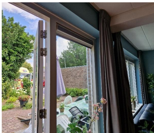
Figuur 3.23: Voorbeeld van een toevoerrooster en de buitendeur
