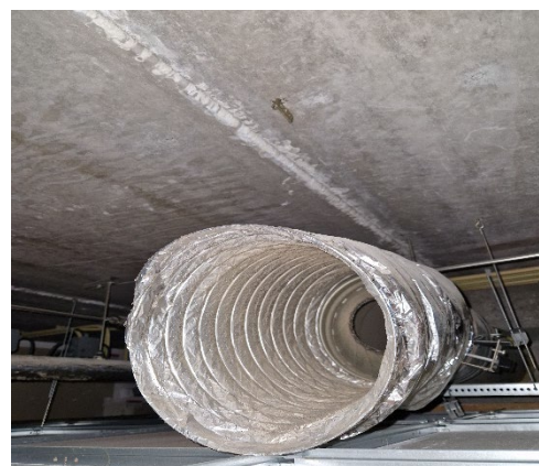
Figuur 3.4 Voorbeeld van een afzuigpunt boven het plenum
