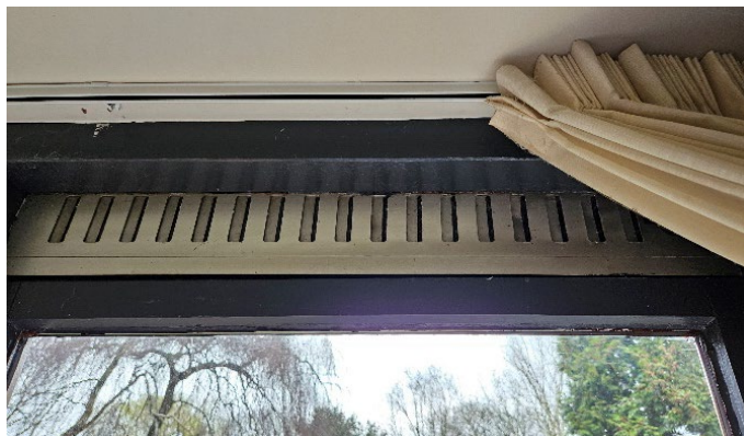
Figuur 3.7 Voorbeeld van een toevoer raamrooster in de ruimte
