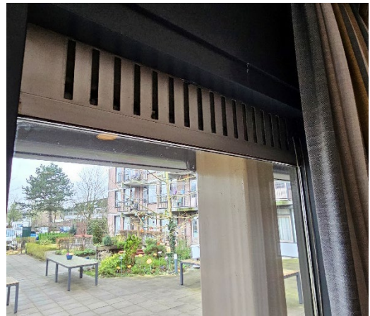
Figuur 3.4 Voorbeeld van een rooster in het raam.
