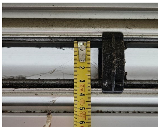
Figuur 2.2: Opmeten netto doorlaat ventilatiooroster.
