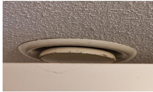
Figuur 3.4 Voorbeeld van afvoerrozet ruimte 1
