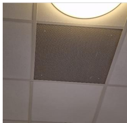
Figuur 4.22: Voorbeeld van het afvoerrooster in ruimte 3
