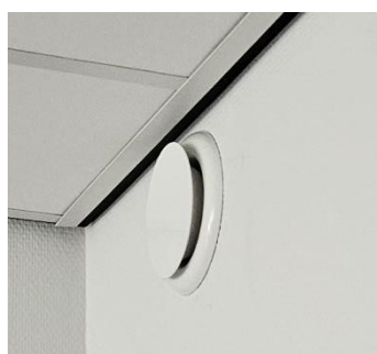
Figuur 5.9: Afvoerpunt in ruimte.
