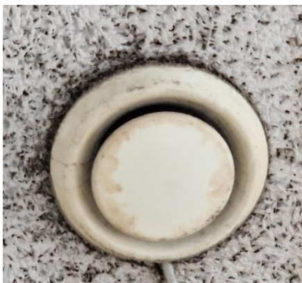
Figuur 5.7: Toevoerrooster in ruimte 2
