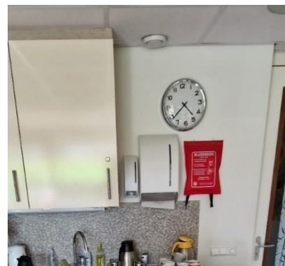
Figuur 6.8 Voorbeeld van afvoerpunt in ruimte 2
