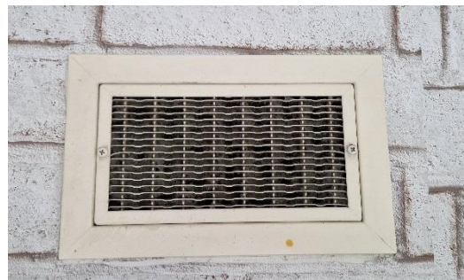
Figuur 5.4: Voorbeeld van afvoer rooster ruimte 1
