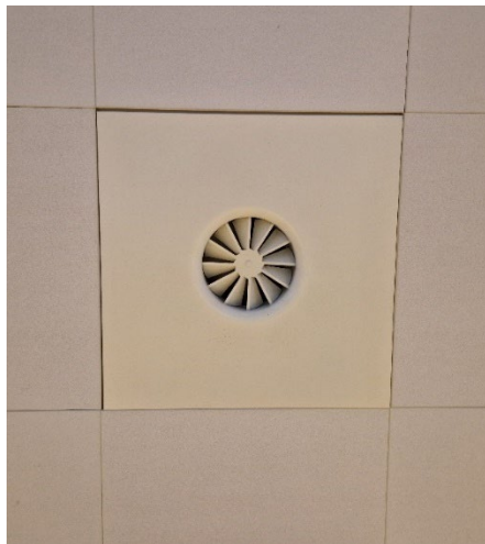
Figuur 5.7 Voorbeeld van een toevoerwervelrooster in de ruimte
