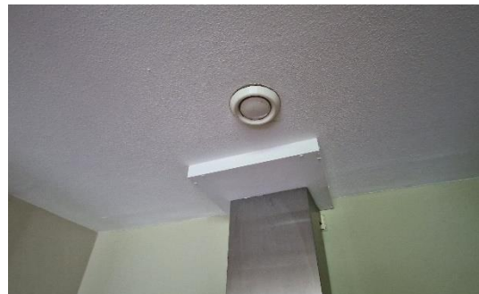
Figuur 3.32: Voorbeeld van afvoer rozet ruimte 3
