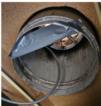
Figuur 5.3: Afvoerpunt in plenum.
