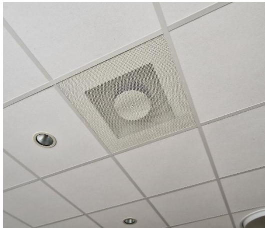
Figuur 4.17: Voorbeeld van toevoerpunt in ruimte 2
