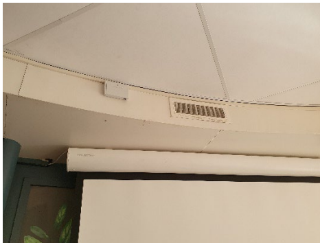
Figuur 5.3: voorbeeld van één toevoerrooster in de ruimte
