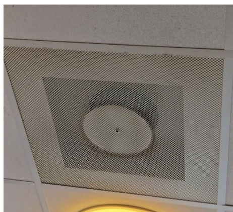
Figuur 4.21: Voorbeeld van een toevoerrooster in ruimte 3
