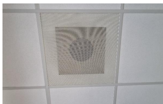
Figuur 4.14: Voorbeeld van een afvoerrooster in ruimte 1
