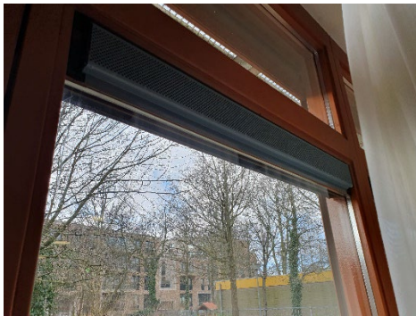
Figuur 5.7: Voorbeeld van een raamrooster in de ruimte
