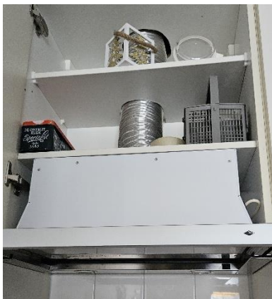
Figuur 4.6: Afzuigkap, mogelijk aangesloten op mechanische afvoer.
