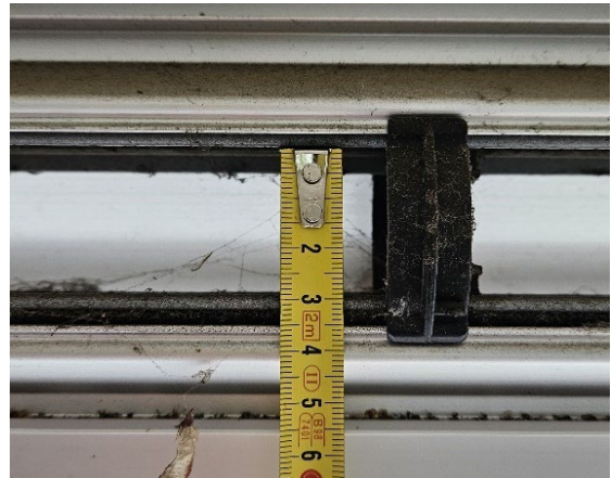
Figuur 2.2: Opmeten netto doorlaat ventilatioeroster.
