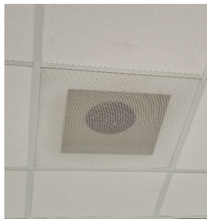
Figuur 4.26: Voorbeeld van afvoerrooster in ruimte 1
