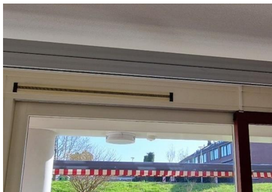
Figuur 6.7 Voorbeeld van ventilatierooster in ruimte 2
