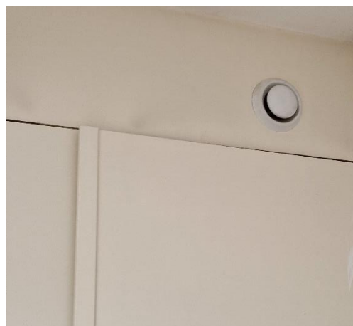
Figuur 4.7: Voorbeeld van afvoer rozet ruimte 2
