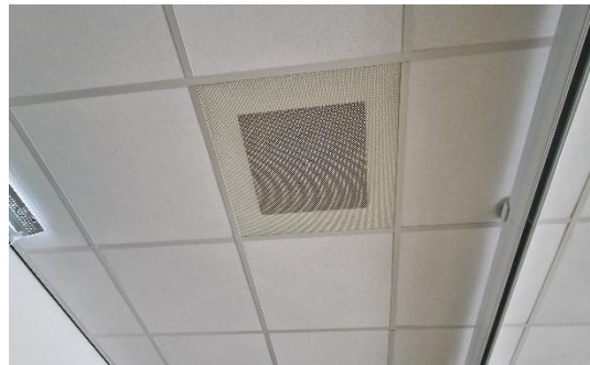
Figuur 4.18: Voorbeeld van afvoerrooster ruimte 2
