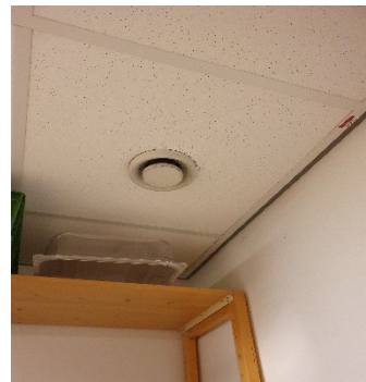
Figuur 5.4: voorbeeld van één afvoer rozet in een aanliggende ruimte
