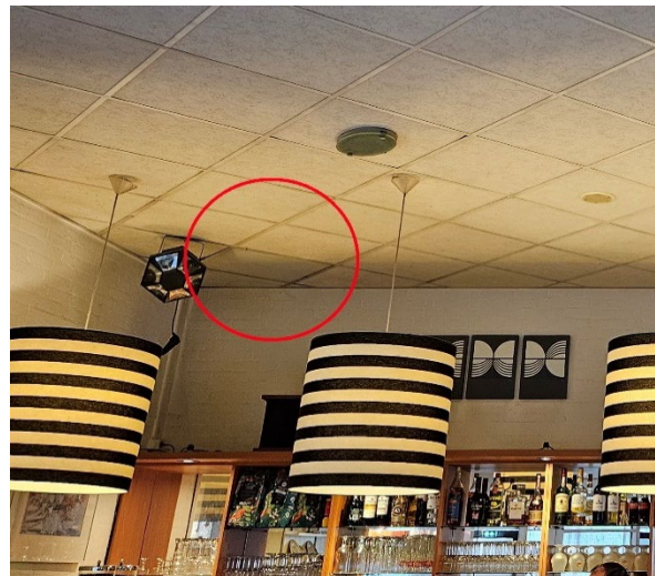
Figuur 8.4 Één van de twee geperforeerde toevoerroosters
