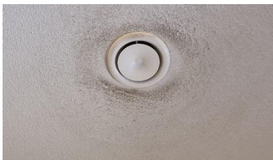
Figuur 3.11: Voorbeeld van toevoer rozet in ruimte 3
