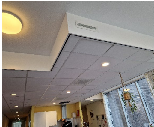
Figuur 4.3 Voorbeeld van een toevoerrooster in de ruimte
