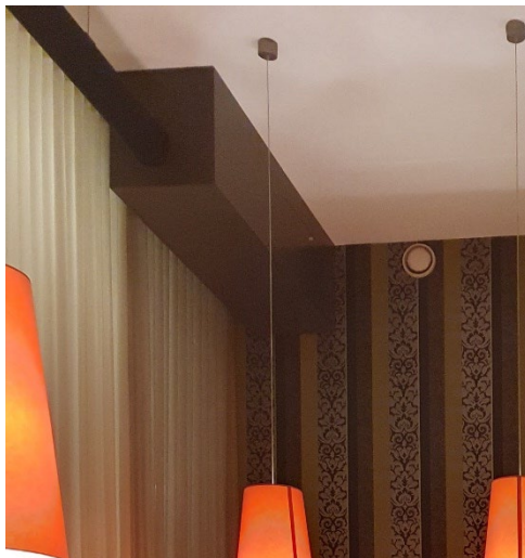
Figuur 4.3 De textiele luchtverdeelslang met omkasting
