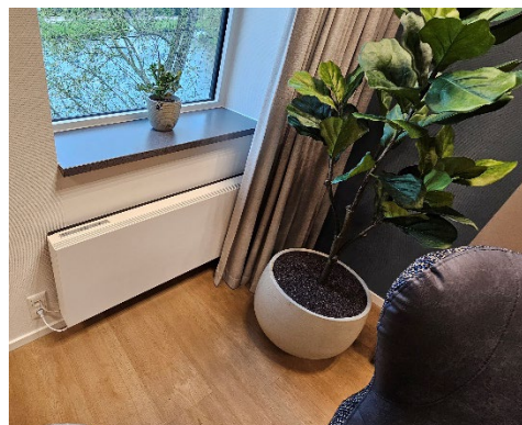
Figuur 4.12 Een ClimaRad ventilatie-unit en een raam.
