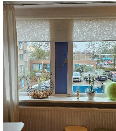
Figuur 10.8 Eén van de te openen ramen
