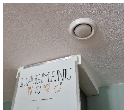
Figuur 3.28: Voorbeeld van afvoer rozet ruimte 2
