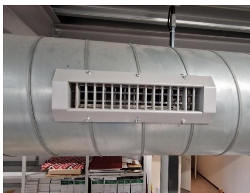
Figuur 5.19 Voorbeeld van een toevoerrooster
