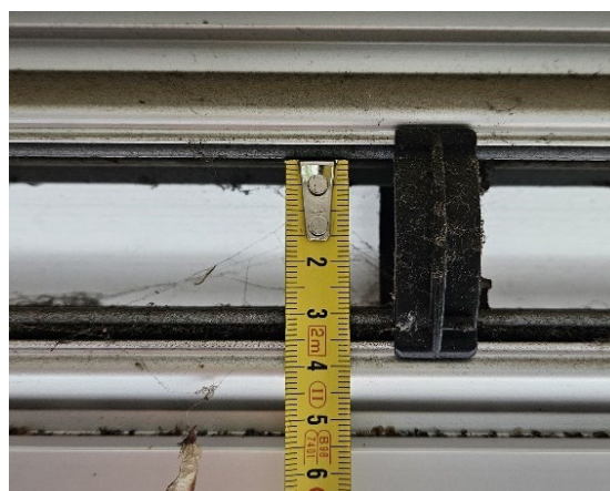
Figuur 2.2: Opmeten netto doorlaat ventilatiooroster.
