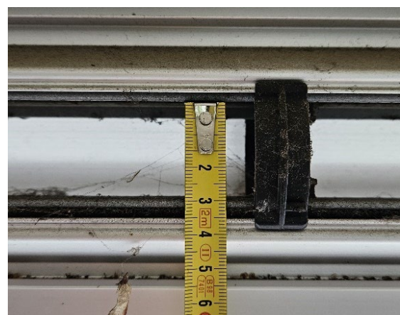
Figuur 2.2: Opmeten netto doorlaat ventilatiooroster.
