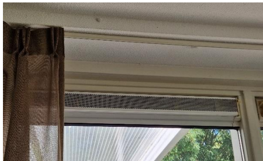
Figuur 3.31: Voorbeeld van toevoer raamrooster in ruimte 3
