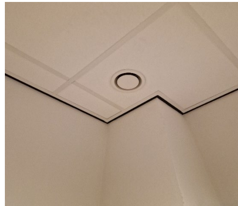
Figuur 4.4 Voorbeeld van een afvoerrooster in de naastgelegen bijkeuken
