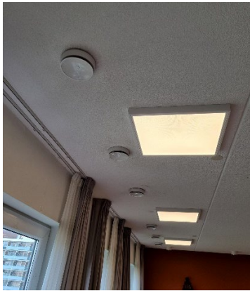
Figuur 4.10: Impressie toevoer rozetten in de ruimte.
