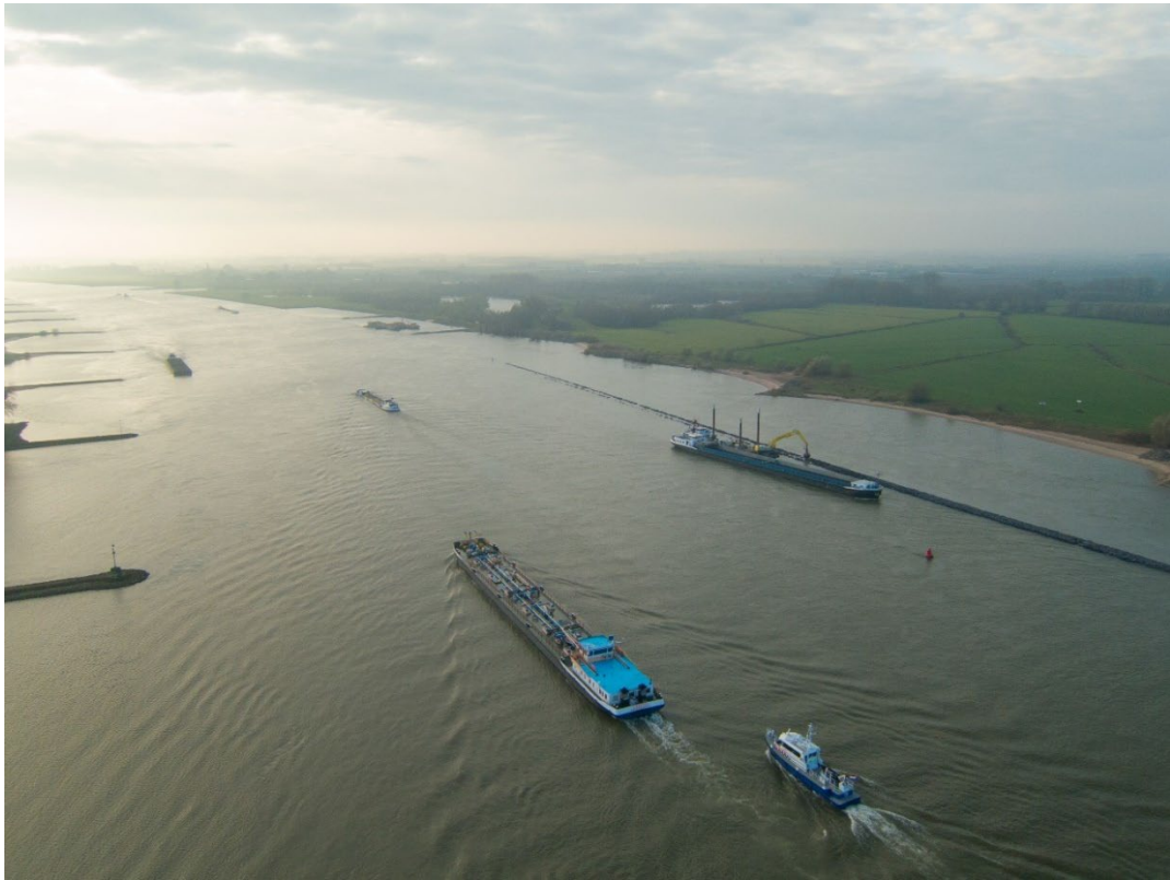
Figuur 5.7: Aanleg van langsdam langs de oever van de Waal in 2014. Langs de linkeroever zijn traditionele kribben te zien. © Rijkswaterstaat | Jasja Vliegt
