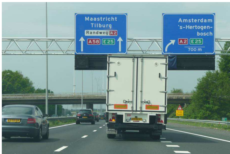
Figuur A6: Voor Knooppunt Ekkersweijer de vooraankondiging van de splitsing van de Randweg Eindhoven en de A2 naar het Noorden.
