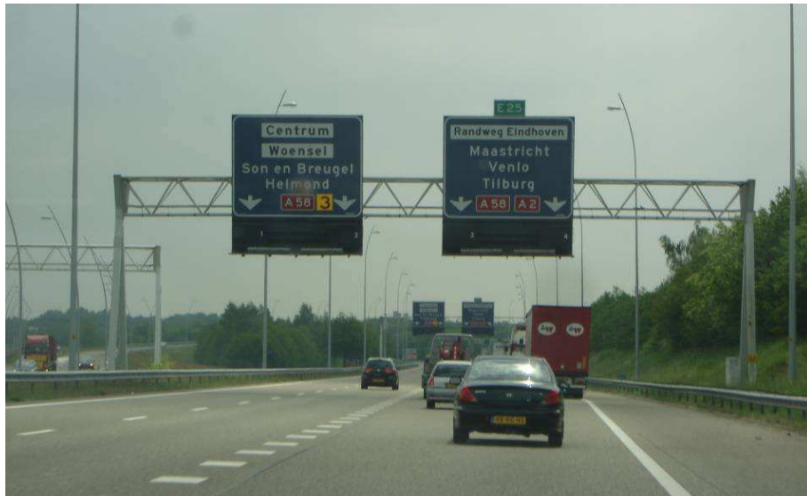
Figuur A1: Nadering Randweg vanuit het noorden bij Knooppunt Ekkersweijer met nog de oorspronkelijke bewegwijzering
