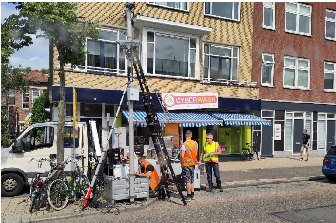
Figuur 3.9: Meetposten op locatie Amsterdamsestraatweg. Boven: meetpost 1 richting Zuid (cam02, westzijde), onder: meetpost 2 richting Noord (cam03), in opbouw.
