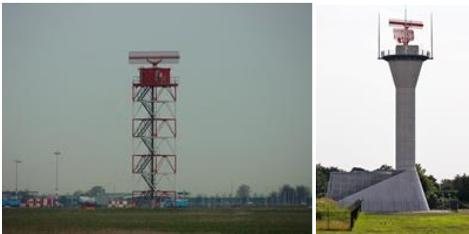
Figuur 16: De TAR 1 of TAR Centrum (links) geplaatst tussen de taxibanen op het vliegveld en de TAR West (rechts) gelegen naast de taxibaan richting de Polderbaan (Bron: LVNL).
