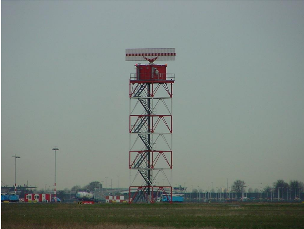
Figuur 13 De TAR Centrum of TAR 1 secundaire radar gelegen tussen de taxibanen van Schiphol.
