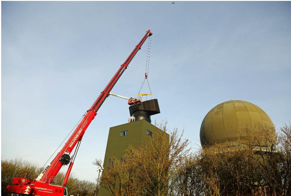
Figuur 58: De plaatsing van de nieuwe SMART-L EWC GB radar naast de bestaande MPR in Wier [Bron: Defensie].
