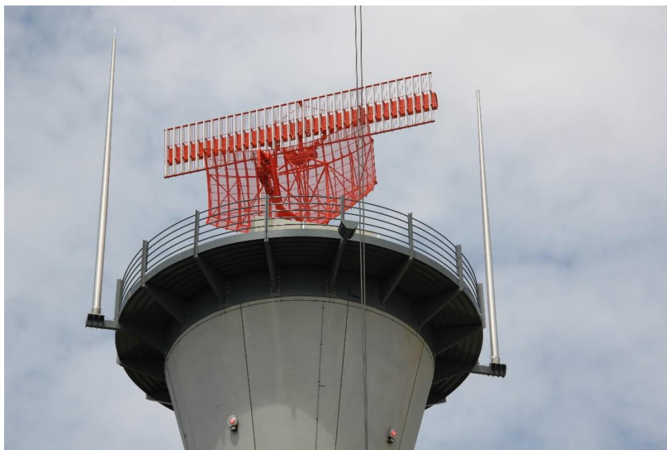
Figuur 6 Een secundaire radar antenne gemonteerd op de STAR 2000 antenne van de TAR West, bestaande uit 35 radar elementen bovenop een STAR 2000 antenne.
