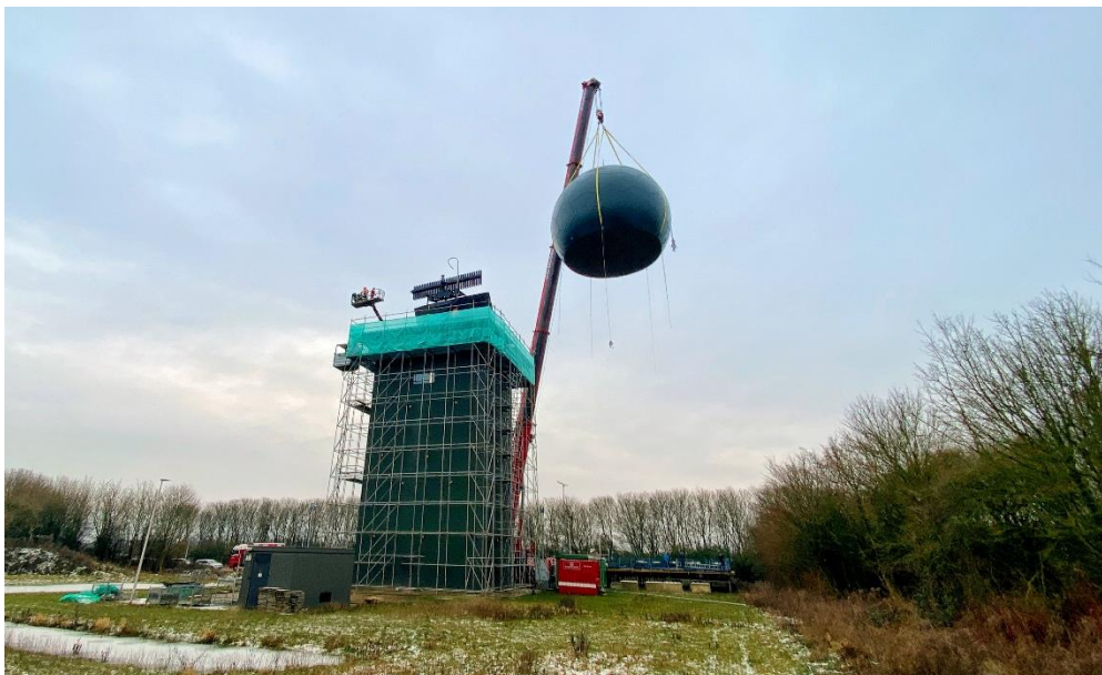
Figuur 59: De plaatsing van de radome over de nieuwe SMART-L EWC GB radar in Wier [Bron: Thales].
