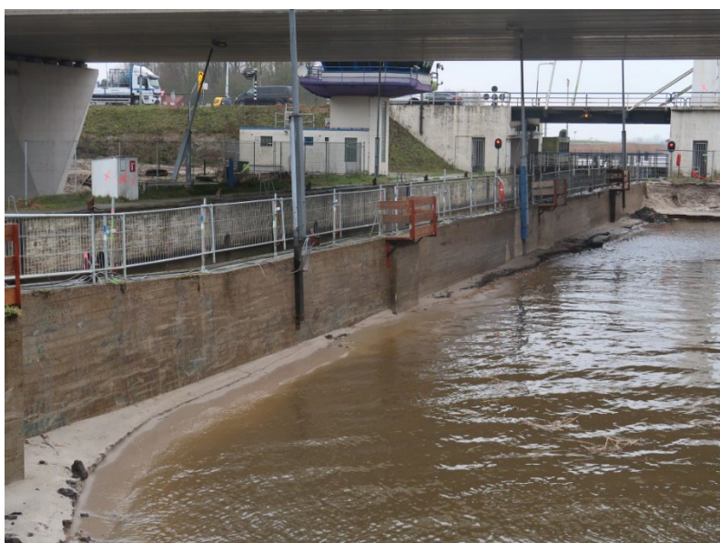
Foto 7: Achterzijde van de kolkwand
