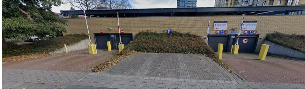
Figuur 23 Voorbeeld van een platdak waarbij [h_dak_min] een foutieve waarde heeft (BAGid)
