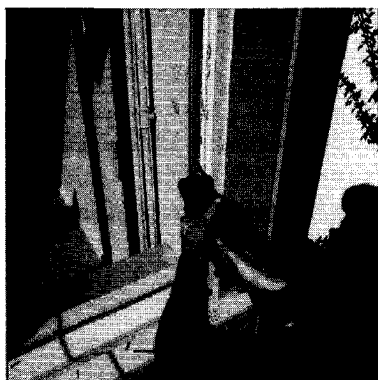
Figuur 6: Met de voegenverwijderaar kan oude kit tussen ruit en kozijn verwijderd worden.
