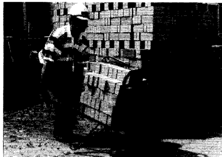
Figuur 1: Traditioneel werk van metselaar en opperman waarbij de metselaar de stenen van het vloeroppervlak moet pakken (foto links) en de opperman zware lasten moet vervoeren (foto rechts).
