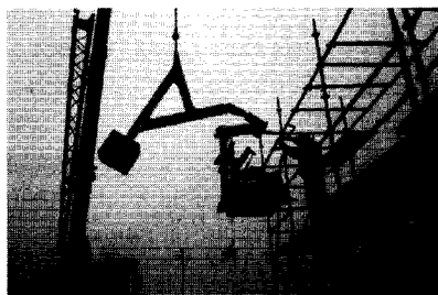
Figuur 2: Verbeterd metselen door verhoogde plaatsing van bakstenen waardoor de metselaar minder hoeft te bukken (foto links). Mechanisch transport van bakstenen met een opsteker en kraantang die de bakstenen oppakt en in de steiger plaatst (foto rechts).
