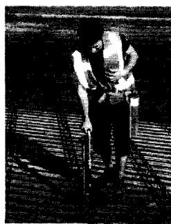
Figuur 4: Voorbeeld van een innovatie met 'beperkte invoering'; de Drillfix voor de betonstaalvlechter [Foto: P. Bos]. De Drillfix wikkelt de draad automatisch om de kruising van de staaldraden.
