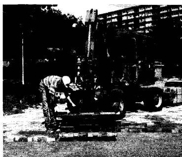
Figuur 3: Voorbeeld van een innovatie met 'beperkte invoering'; een bestratingsmachine voor de stratenmaker [Foto: D. Vader]. De machine pakt pakketten stenen of banden en plaatst ze machinaal in verband.
