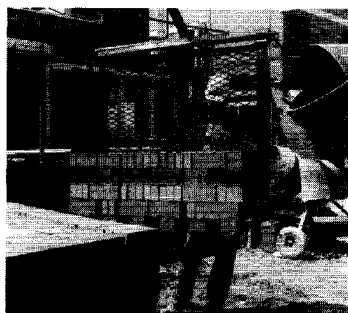
Figuur 2: Voorbeeld van een innovatie met succesvolle invoering; de 6-voetstang voor de opperman voor mechanisch transport van bakstenen. Deze tang is te gebruiken met een kraan of een verreiker waarmee happen van 200 bakstenen op de metselplek geplaatst worden.
