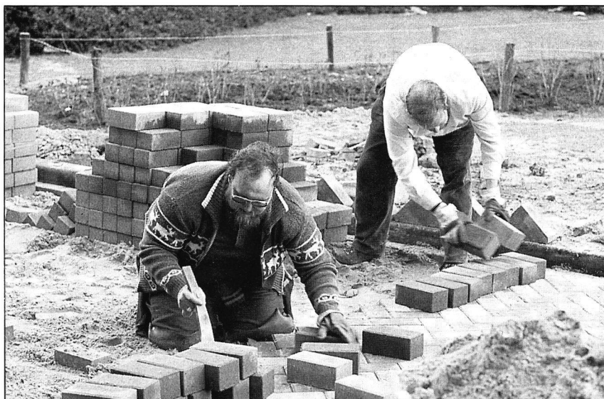
Bij de verwerking van klinkers komen ongunstige werkhoudingen voor. Dat geldt zeker ook voor het 'opperen', het schoonmaken van oude materialen en het klaarleggen van het bestratingsmateriaal. Foto: BGBouw.
