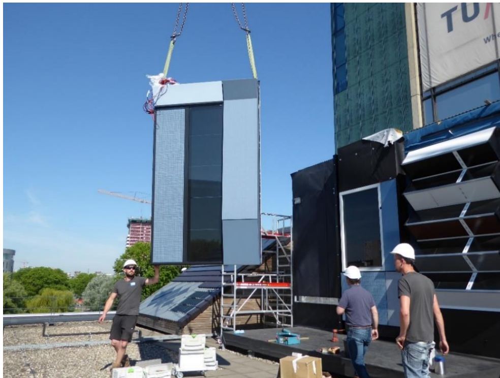
Figuur 8: Installatie van het prefab gevelelement
