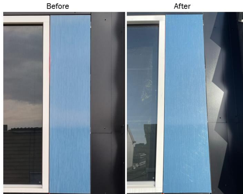
Figuur 15 Paneel E voor en na het vervangen van de gekleurde folie
