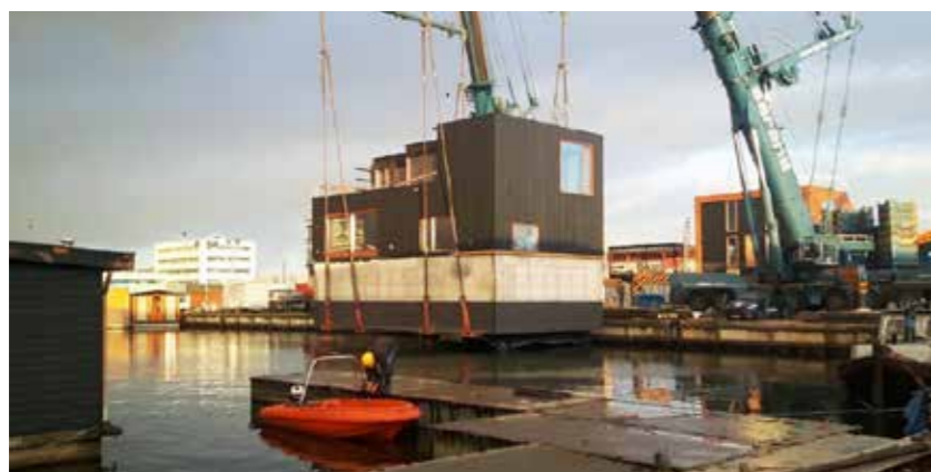
Figuur 5: Bouw en regionaal transport van drijvende woningen bij Cityport voor project Schoon Schip in Amsterdam-Noord.
