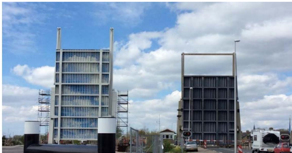
Figuur 22 Oude en nieuwe brug Meppelerdiepsluis tijdens de vervanging (foto Rijkswaterstaat).
