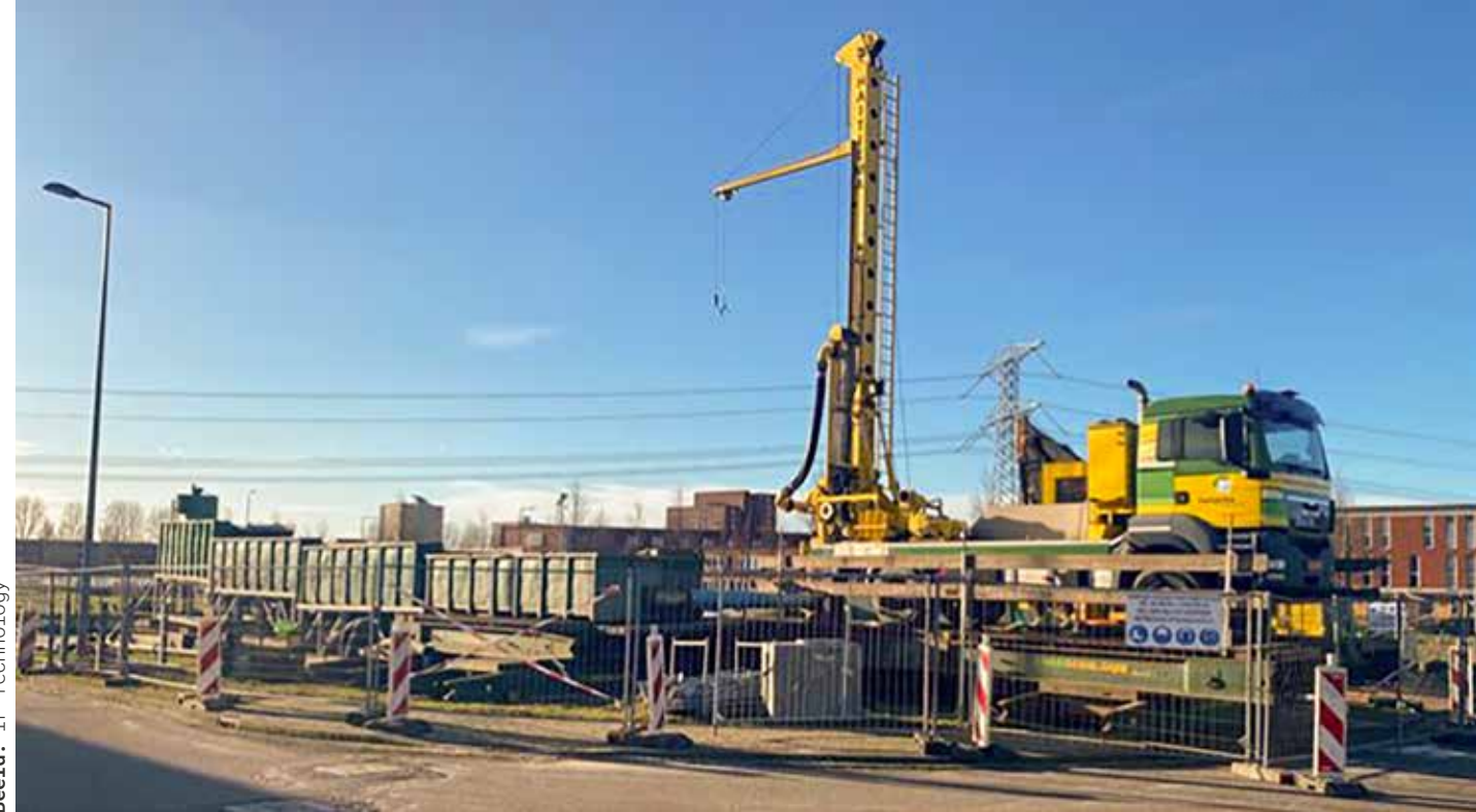
Boorinstallatie tijdens de proefboring in Rotterdam
