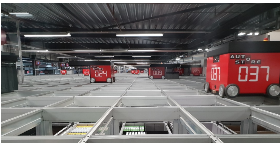
Een automatisch magazijn van autostore. Bron: TNO
