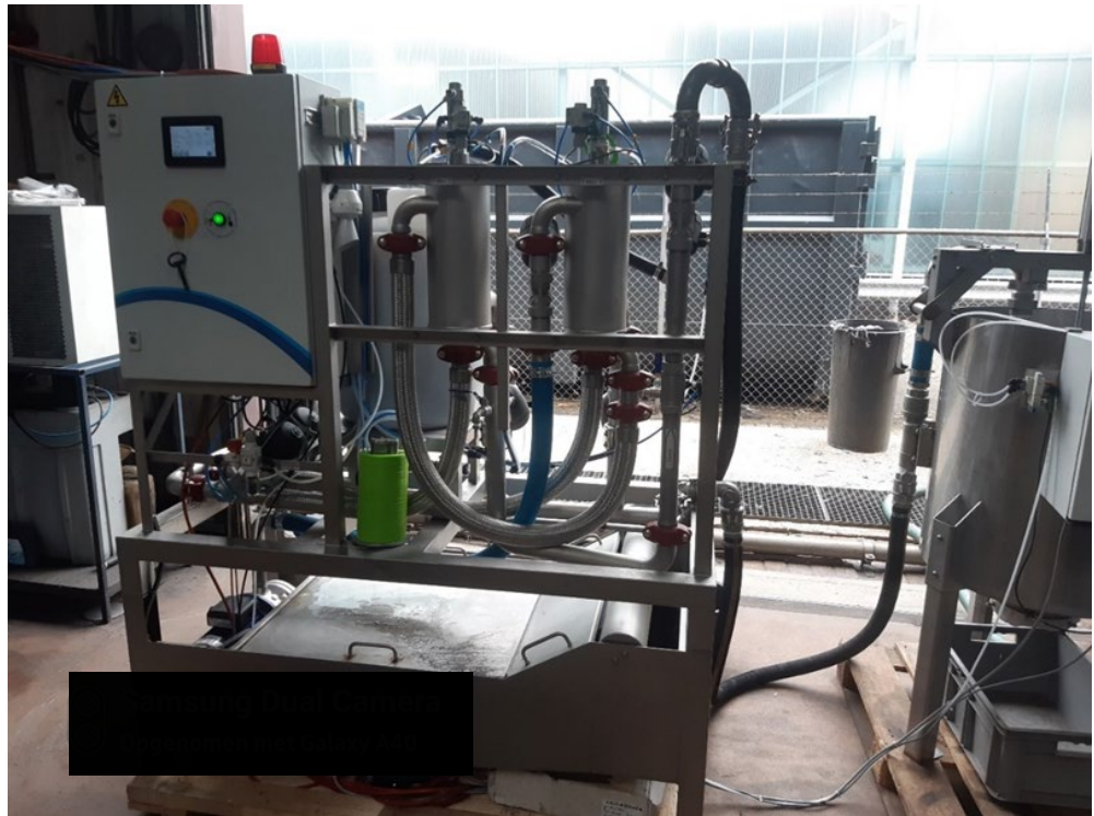
Figuur 4. Filterinstallatie werkkledingwasserij
