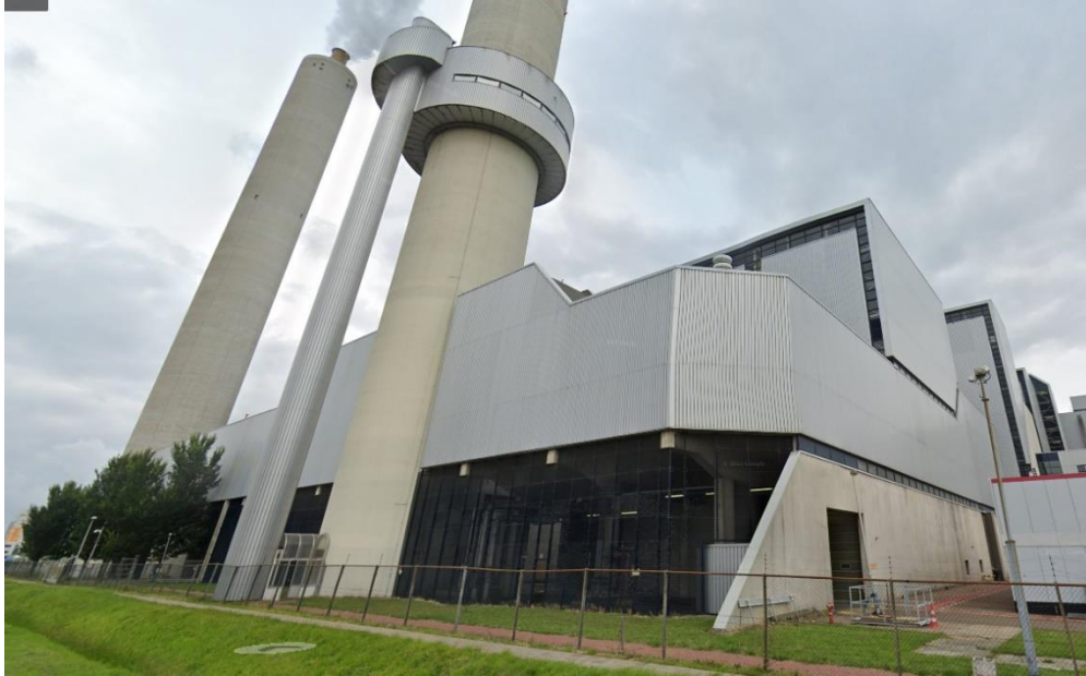
Figuur 10 Een trafo zonder vbo; het Amsterdams afvalverwerkingsbedrijf, een groot industrieel complex.
