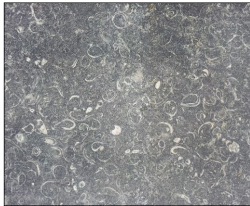
Figuur 6.1 Gesteente van Dinantien-ouderdom in de vloer van het TNO-gebouw in Utrecht, met veel schelpfragmenten. De permeabiliteit is zeer laag.
