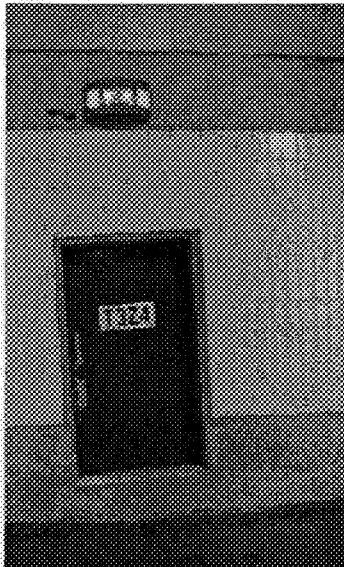
Fig. 10 Huidige en nieuwe uiterlijk van de vluchtdeur. (Verlichte pictogram niet te hoog maar direct op de bovendorpel, deurblad alleen nog gemarkeerd met het rennende mannetje; deurblad verlicht; en openingswijze duidelijk aangegeven met pijl. Schets rechts afkomstig uit conceptstuk "Veiligheidsrichtlijnen", Rijkswaterstaat.)
