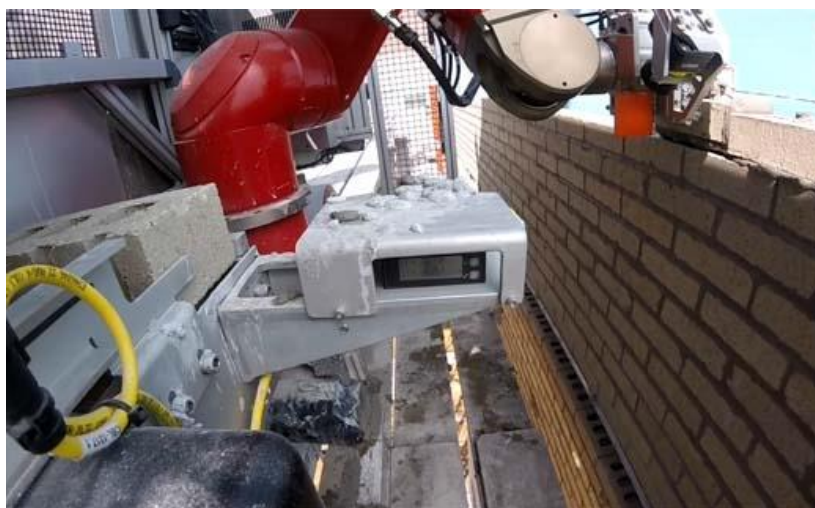
Figuur 4: Metselrobot van Construction Robotics, op de bouwplaats. (bron: internet).
