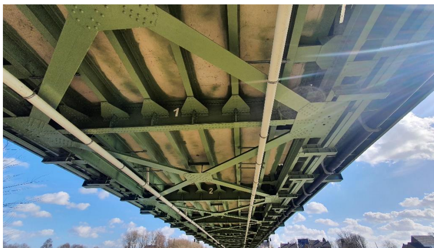
Figuur 2 Brug Berg in Urmond met betonnen hoofdrijdek en fietspaden op consoles.
