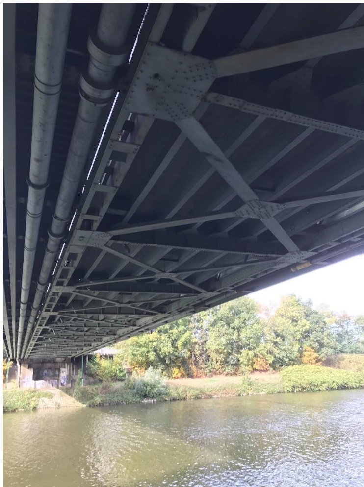
Figuur 12 De bestaande brug Urmond, Mauritsweg, onderzijde (foto Rijkswaterstaat).
