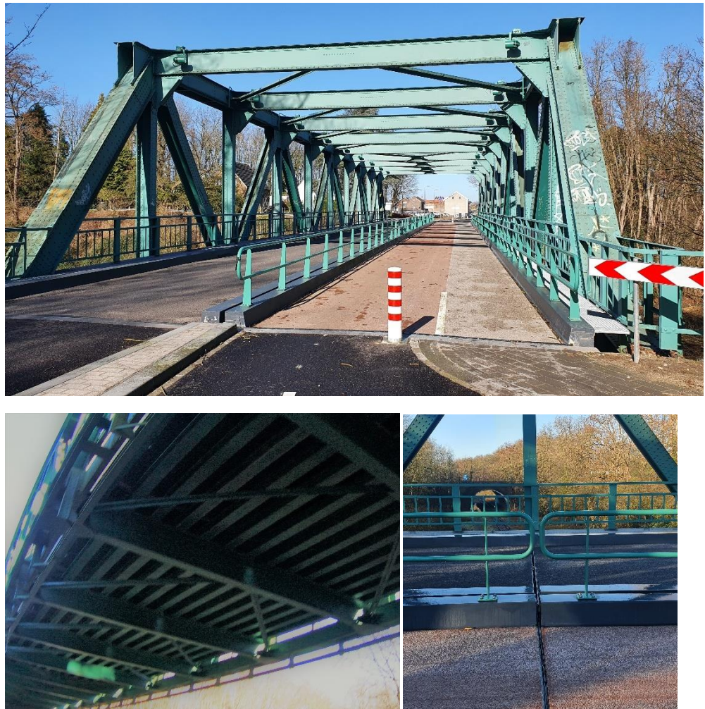
Figuur 1 Burg Locht bij Kerkrade, met vierdelig VVK dek. Boven: bovenzijde, linksonder: onderzijde, rechtsonder: dwarsvoeg in beide dekken.
