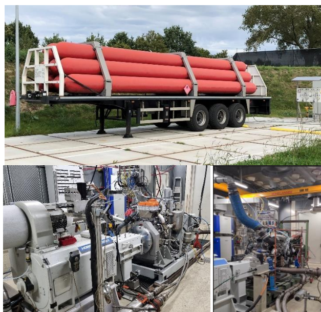
図 1 オランダ・ヘルモントの TNO の水素インフラと試験施設 圧縮水素はチューブトレーラーに貯蔵され、最大 700kW の多気筒エンジンとヘビーデューティ単気筒エンジンを運転できる、最大 4 つの実験室に水素を供給します。
