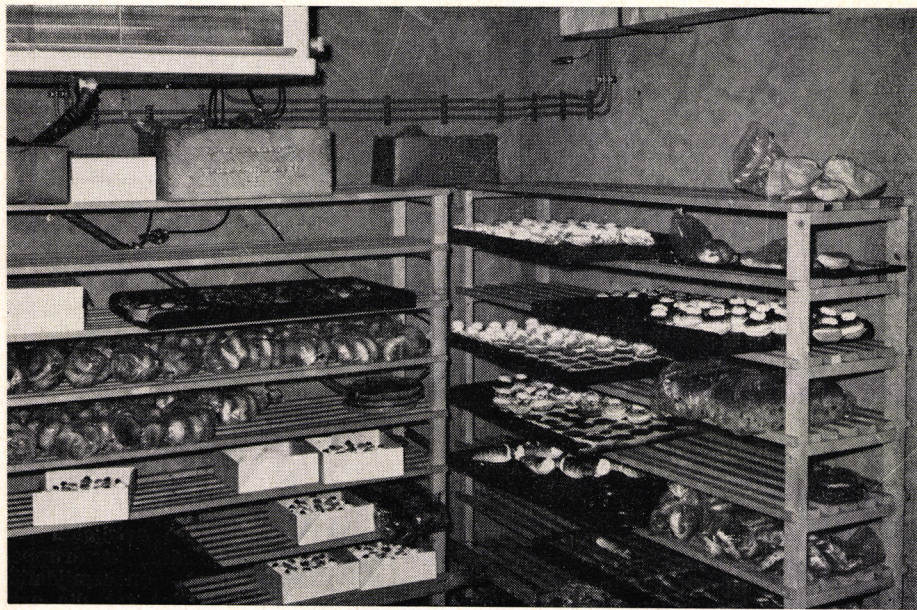
Afb. 1. Interieur van een diepvriesbewaarcel. In dit gedeelte van de cel zijn vooral banketartikelen opgeslagen
