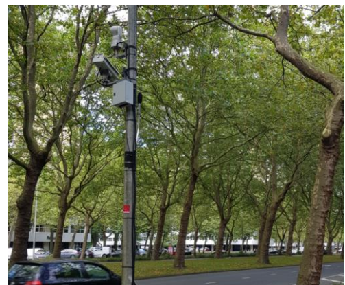
Meetpost rijbaan richting Noord
