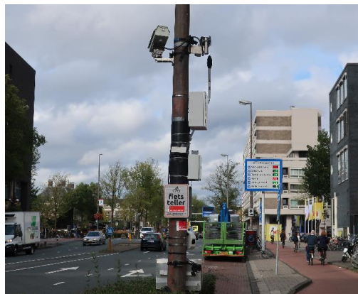
Meetpost rijbaan richting Noord
