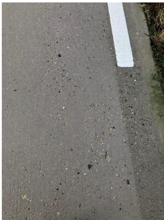
Figuur 33. Project Provincie Overijssel: in het werk gestort geopolymer beton.
