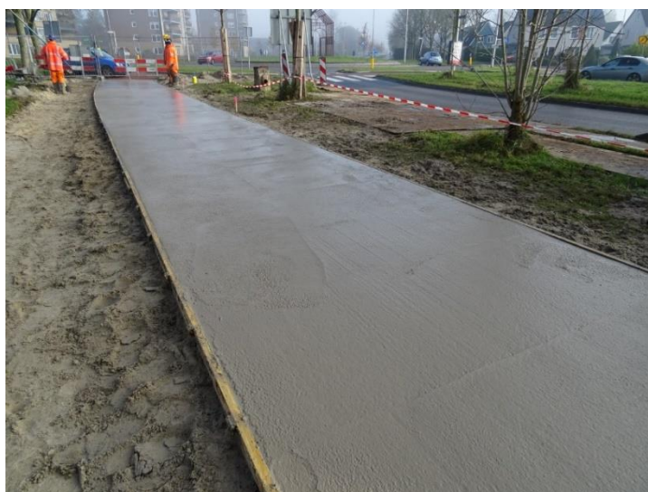
Figuur 21. Pilot Gemeente Leeuwarden: geopolymeer beton circa halve dag na het storten.
