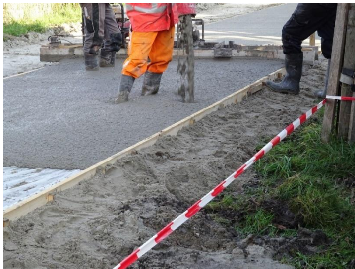
Figuur 19. Pilot Gemeente Leeuwarden: storten geopolymeer beton.
