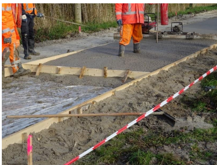
Figuur 20. Pilot Gemeente Leeuwarden: geopolymeer beton kort na storten.
