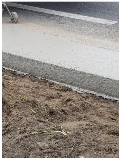
Figuur 8. Pilot Provincie Gelderland: geopolymeer bermbeton bij oplevering.
