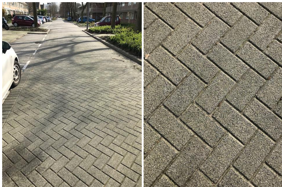
Figuur 11. Pilot Gemeente Rotterdam: geopolymer betonstraatstenen met cement gebonden toplaag in Goudkruid na 6 maanden.
