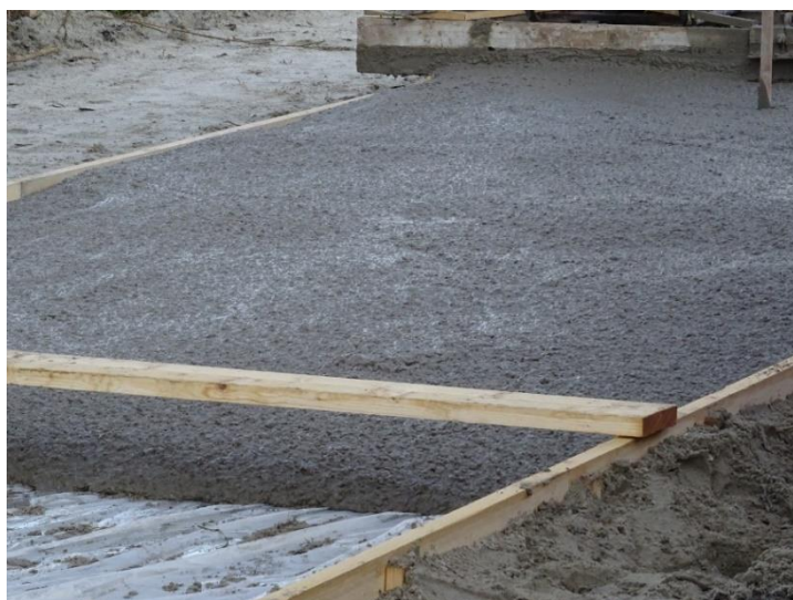
Figuur 19. Pilot Gemeente Leeuwarden: storten geopolymeer beton.
