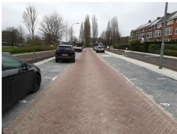
Figuur 27. Pilot Gemeente Dordrecht: overzicht van het werk; de parkeervakken en trottoirs zijn uitgevoerd in betonwaren, de rijbaan in gebakken klinkers.
