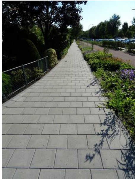
Figuur 28. Pilot Gemeente Dordrecht: geopolymer betontegels.
