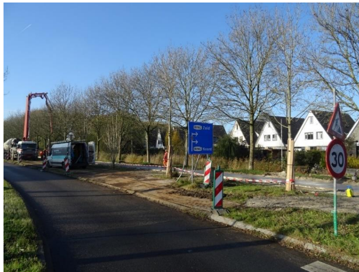
Figuur 18. Pilot Gemeente Leeuwarden: overzicht werk. Het te storten fietspad bevindt zich achter het rood-witte lint.
