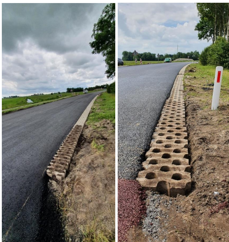
Figuur 31. Pilot Provincie Groningen: overzicht van het werk.
