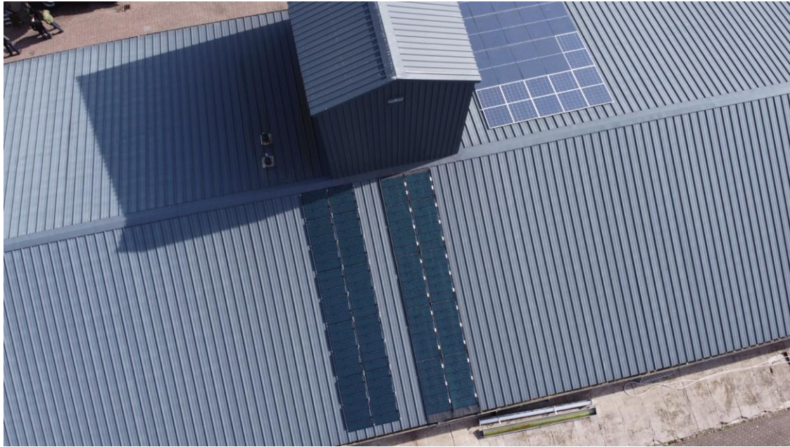
Drone shot vlak voor het middaguur wanneer het STAL-systeem op het onderste dakvlak (West-georiënteerd) uit de schaduw komt van de hoge opbouw. Links 2 PV-panelen en rechts 2 PVT-panelen.
