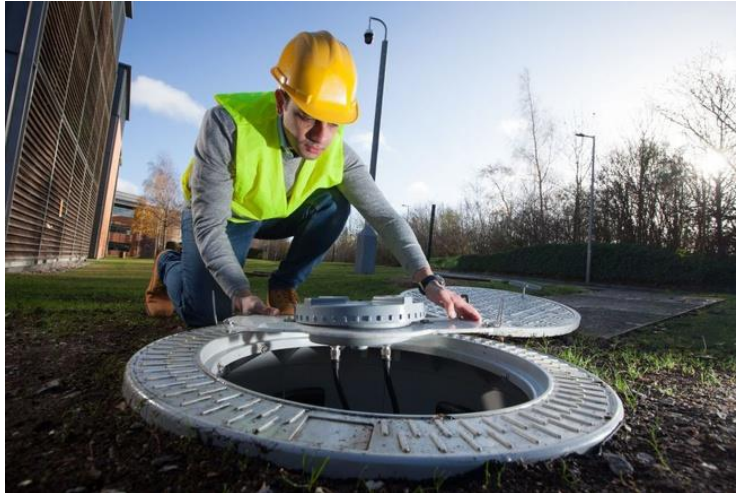
Figuur 6: Small cell-antenne, geïntegreerd in een putdeksel [bron: Vodafone UK 59 ]
