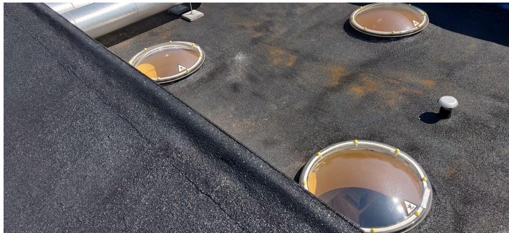
Figuur 41 Lichtkoepels bij lokaal N2 staan vol in de zon en zorgen voor opwarming van het lokaal.
