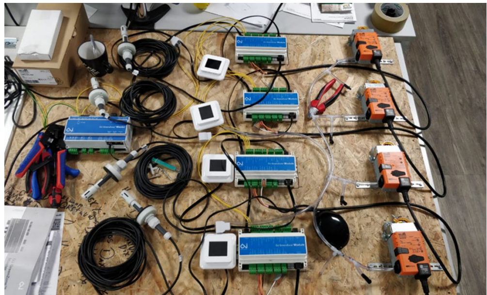
Figuur 26 Testopstelling van temperatuur en CO 2 -regeling per lokaal.
