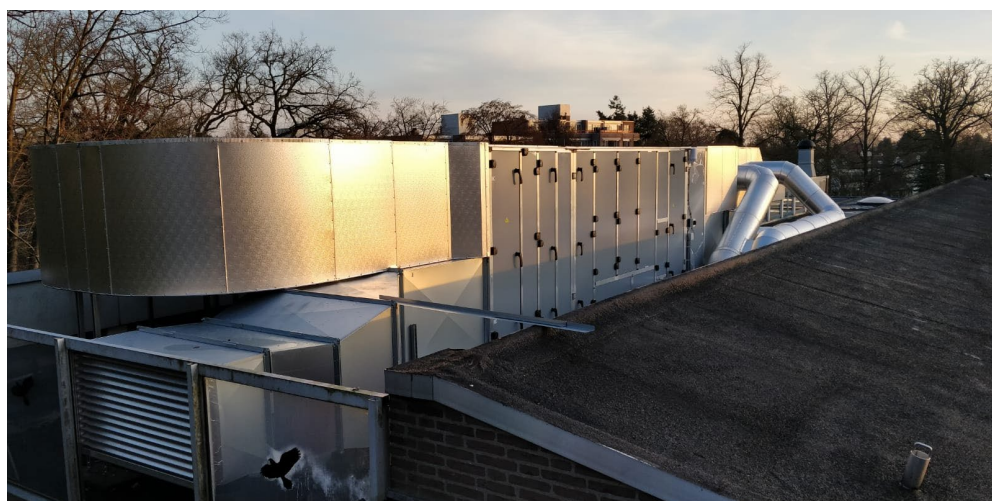
Figuur 52 Isoleren luchtkanalen november/december 2019.
