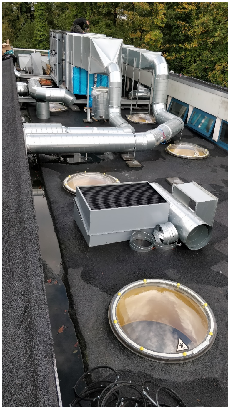
Figuur 51 Monteren luchtkanalen en appendages 17 oktober 2019.
