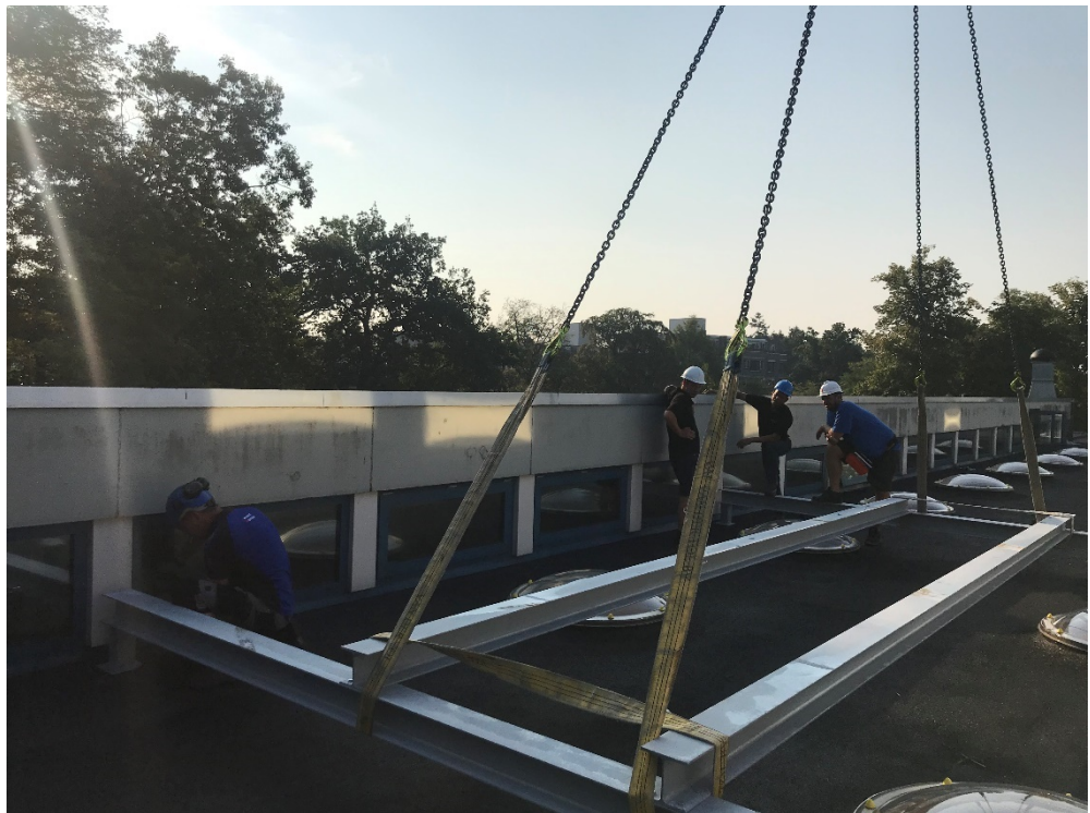
Figuur 49 Plaatsing frame op 27 augustus 2019, tijdens vakantie om hijsrisico's te beperken.
