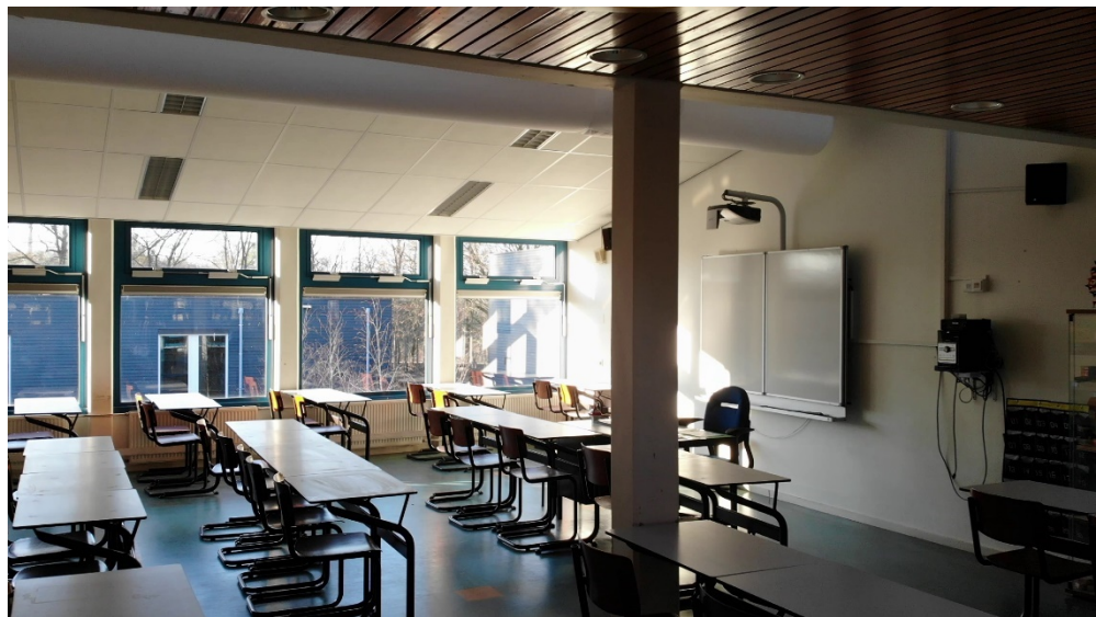
Figuur 27 Testlokaal N3 met inblaasslurf.
