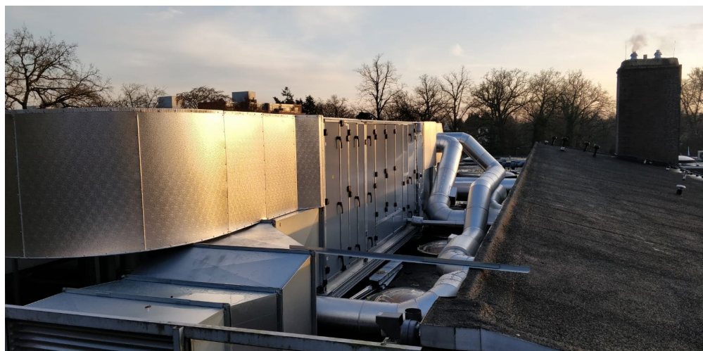
Figuur 28 Luchtbehandelingskast met linksonder het aanzuigrooster in de noordgevel.
