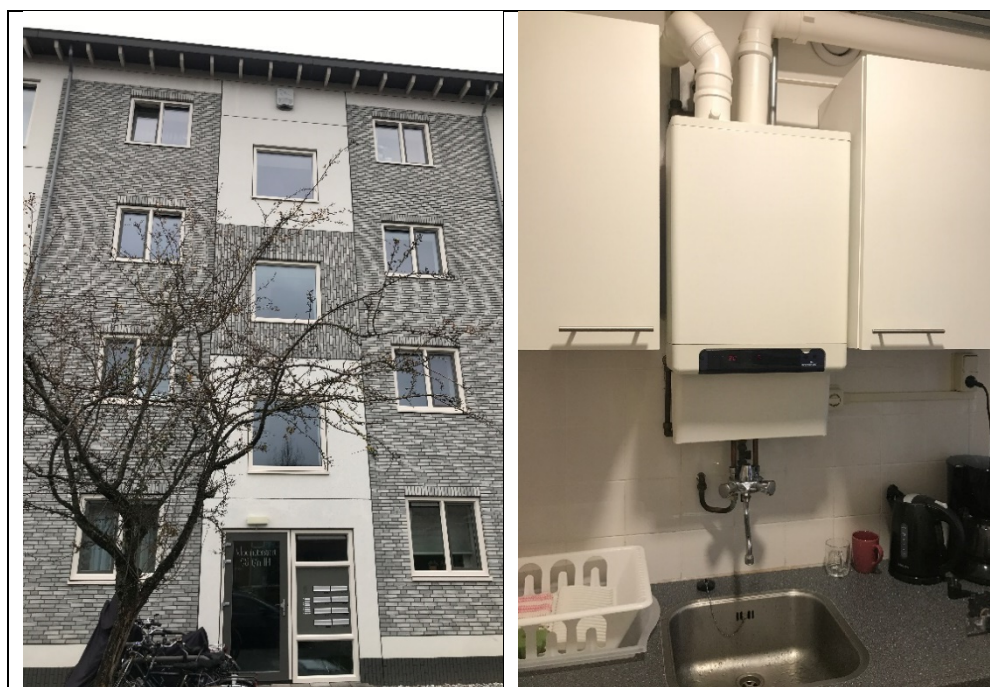
Figuur 4 Portiek flatwoningen in Moerwijk Oost na renovatie: links EPS gevel met steen strips, rechts CV-ketel voor verwarming en warmtapwater.
