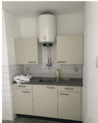
Figuur 3 Bestaande situatie, 120 l elektrische boiler tussen keukenkastjes.
