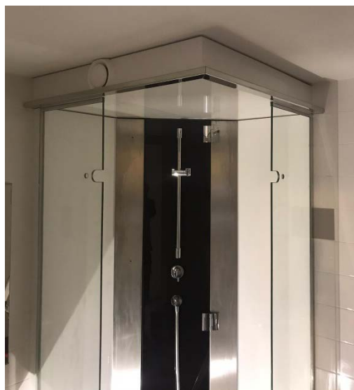
Figuur 9 GroenWest, 'loos' ventilatieventiel in afwerkplint.
