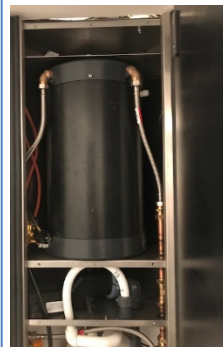
Boiler geplaatst in RVS kolom
