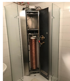
Warmtewisselaar gemonteerd in RVS kolom
