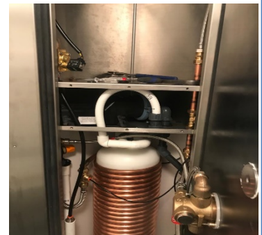
Pomp gemonteerd in RVS kolom
