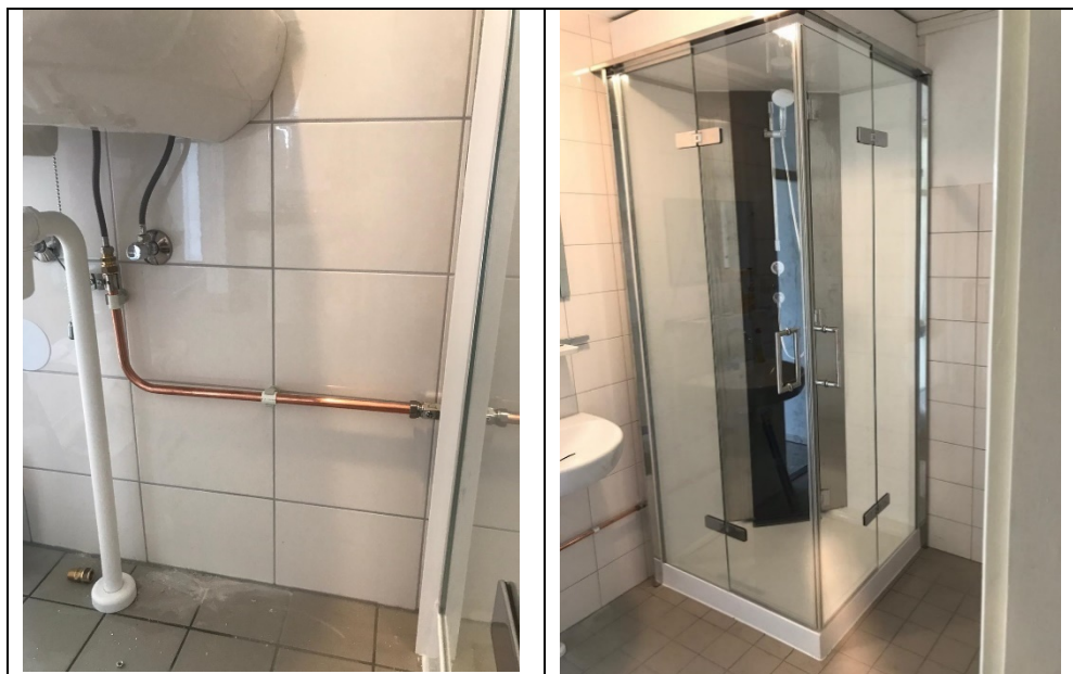
Figuur 7 Aansluiting warmwaterkraan bij de wastafel in de badkamer op RenoDouche (Vidomes 2).
