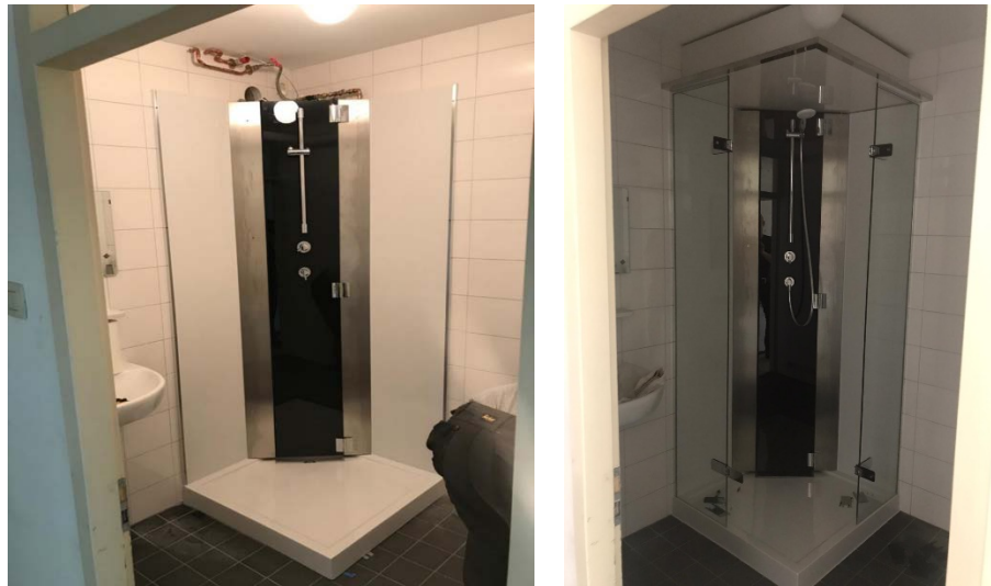
Figuur 8 Vidomes 1, ventilatieafvoer en drinkwateraansluiting boven douchecabine. Op de rechterfoto is de afwerkplint met daarboven een luchtspleet zichtbaar.
