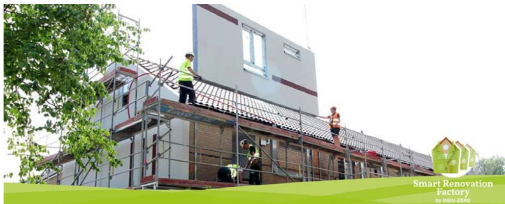
Figuur 3: Gevelrenovatie rijwoningen met prefab-elementen.
