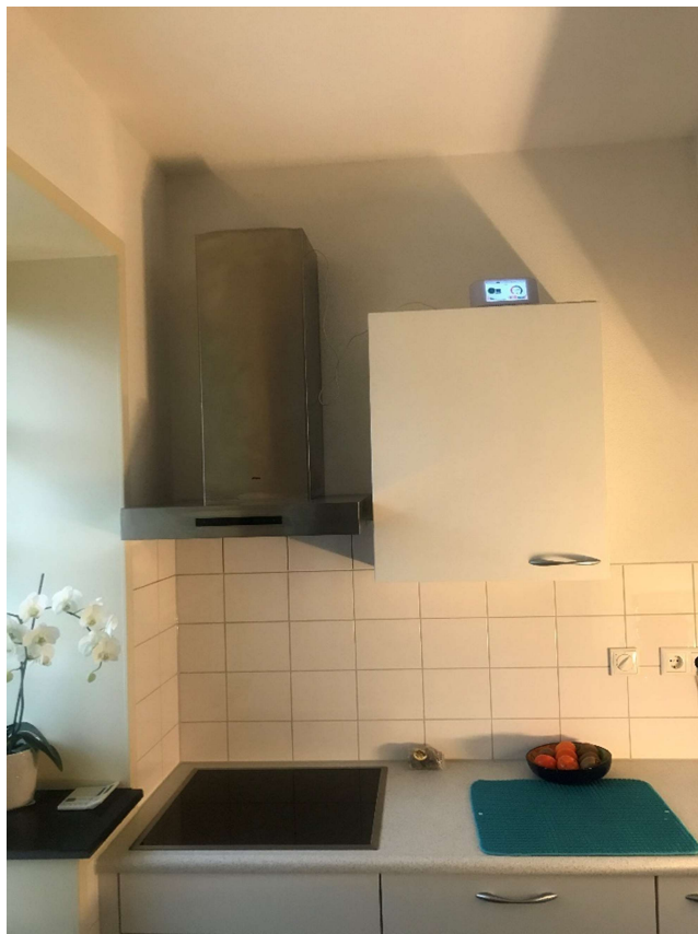
Figuur 26 Inductiekookplaat met daarboven recirculatieafzuigkap ATAG WS602112IM, het Airvisual meetapparaat is op het bovenkastje geplaatst.
