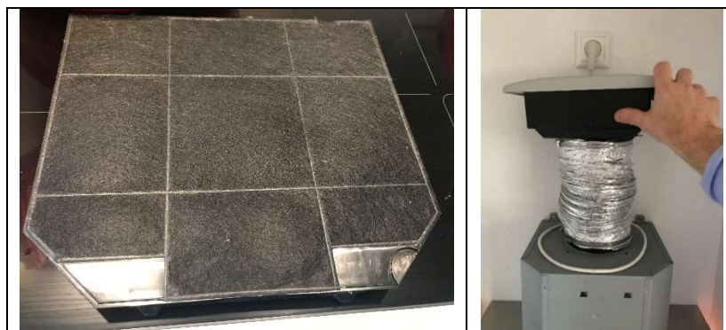
Figuur 25 Links koolfilter direct boven vetfilter, rechts aansluiting filterbox met F7 filter op afzuigkap
