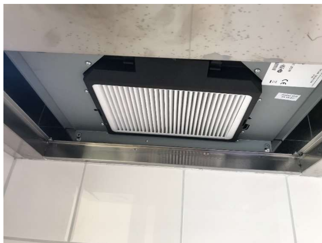
Figuur 27 Plat F9 filter wat op 26 maart aan het eind van de meetperiode is geplaatst in plaats van het koolfilter aan de onderzijde en het fijnstof filter aan de bovenzijde in de filterbox.
