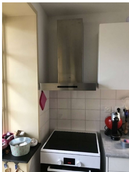
Figuur 24 Inductiekookplaat met daarboven recirculatieafzuigkap ATAG WS602112IM, rechtsboven is het Airvisual meetapparaat nog net zichtbaar.
