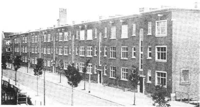
Vooraanzicht van de proefwoningen TNO aan de Fazantstraat te Rotterdam.
