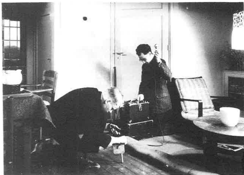
Uitvoeren van contactgeluidmetingen door J.P. van Wisselingh en L.M.C. Touw.
