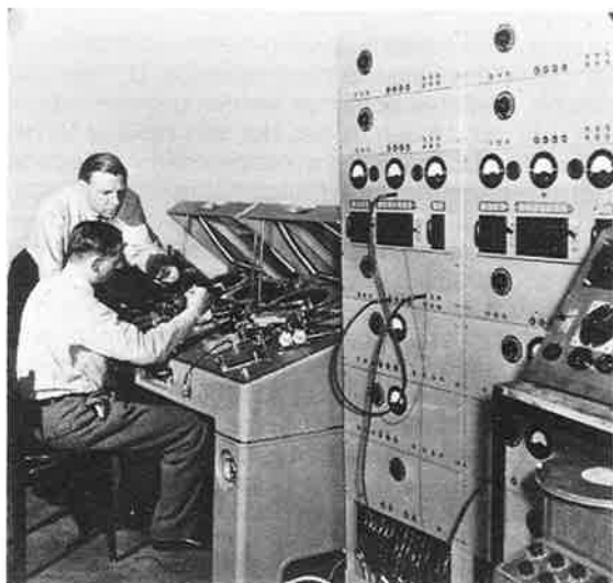
De Philips-Miller-machine met een gedeelte der versterkerrekken enz., zoals die opgesteld stonden in het Concertgebouw te Amsterdam.
