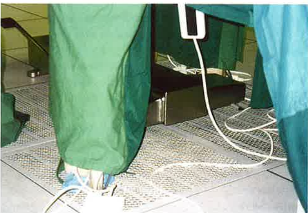
Geperforeerde vloer onder de tafel voor vloerafzuiging
