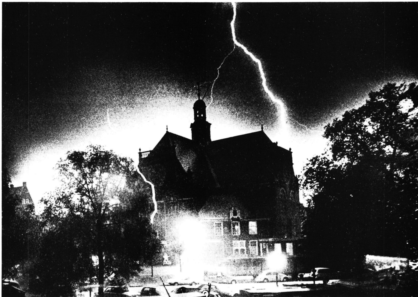
Blikseminslag in de Amsterdamse Noorderkerk. De schade bleef beperkt tot het raderwerk van de klok. Foto: ANP-Foto
