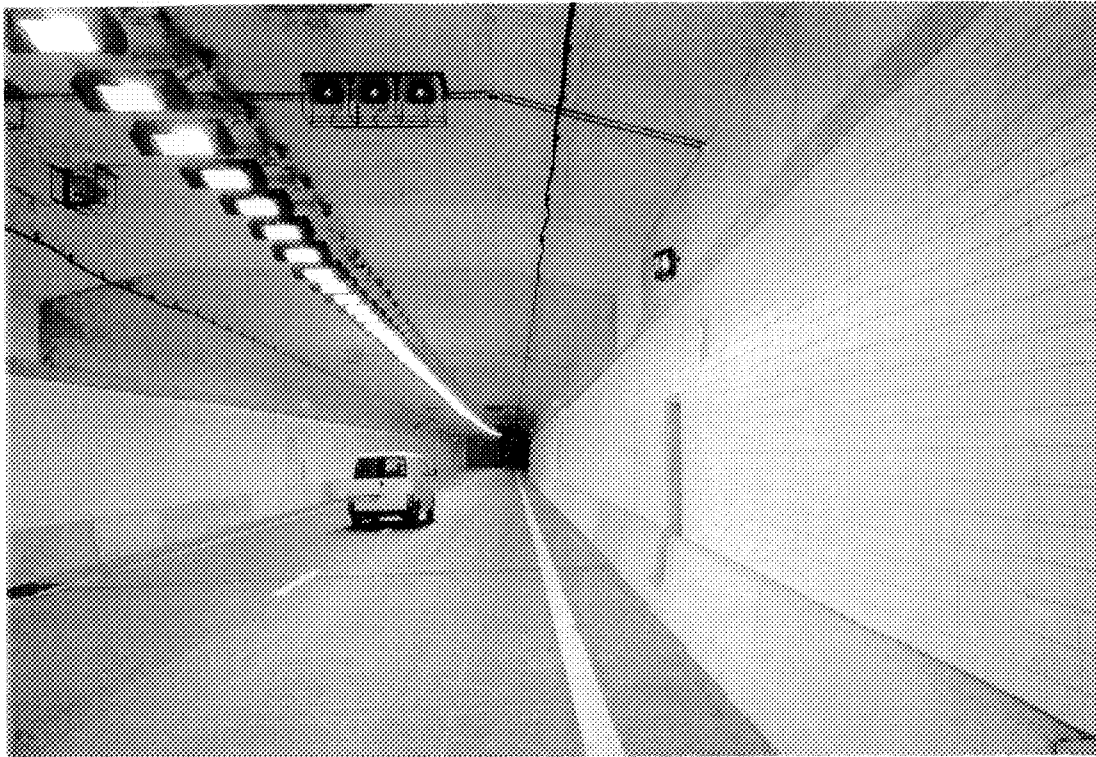
Fig. 1 Tunnel onder de Noord met boven de hulpkasten witte en boven de vluchtdeuren groene bordjes.
