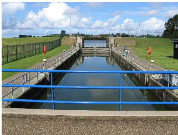
Alkali Silica Reactie (ASR) in een sluis
